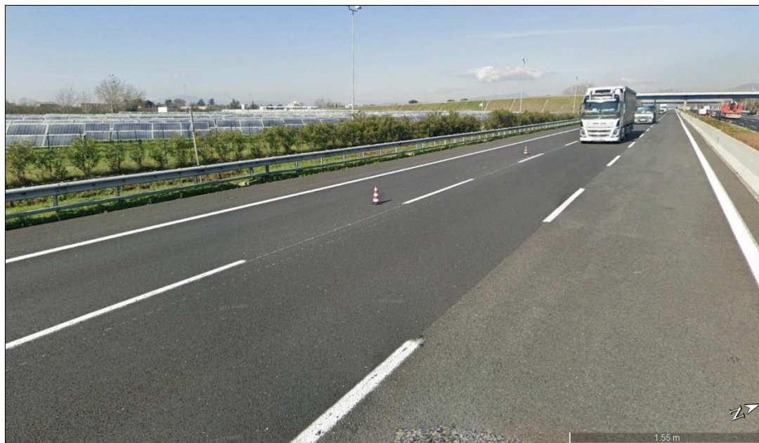
Figura 7: Particolare dell'impianto fotovoltaico sulla Autostrada A1 a Nord Ovest di Caserta
