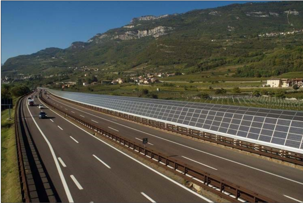
Figura 4: Barriera fonoassorbente fotovoltaica sulla Autostrada del Brennero
