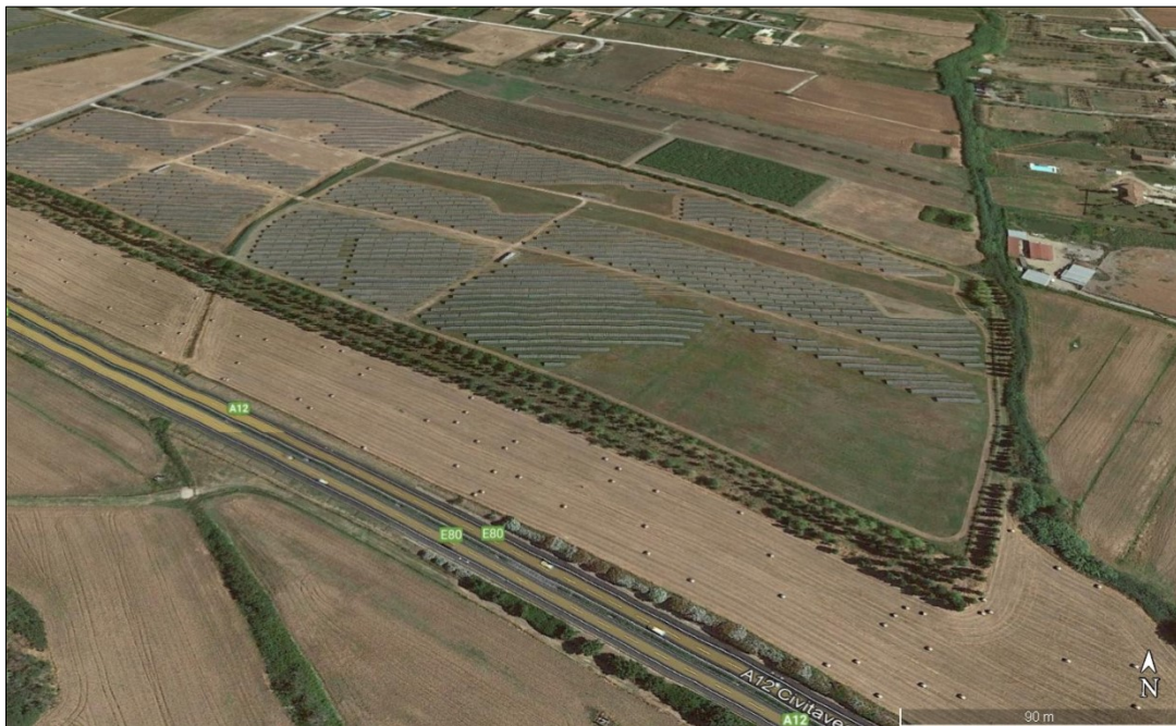
Figura 5: Impianto fotovoltaico sulla A12 Civitavecchia-Roma
