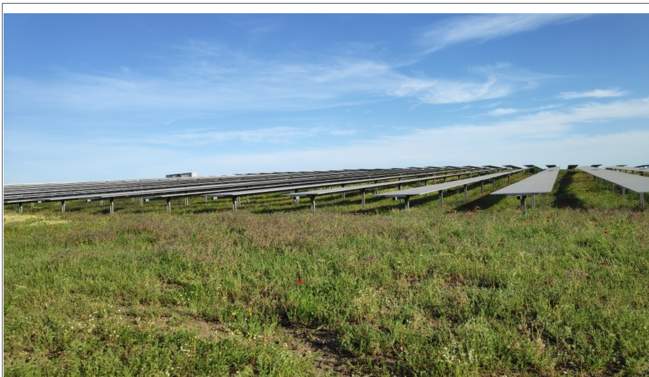
Illustrazione 8: Esempio di inseguitori mono-assiali. Sullo sfondo si nota anche una power station
