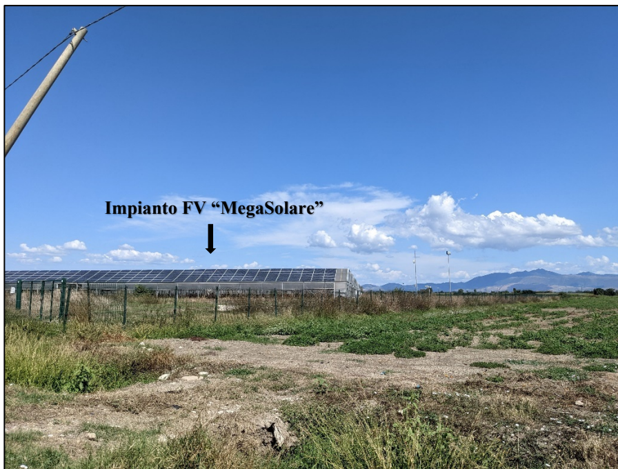
Figura 45: FOTO 5 – vista nei pressi dell'impianto MegaSolare
