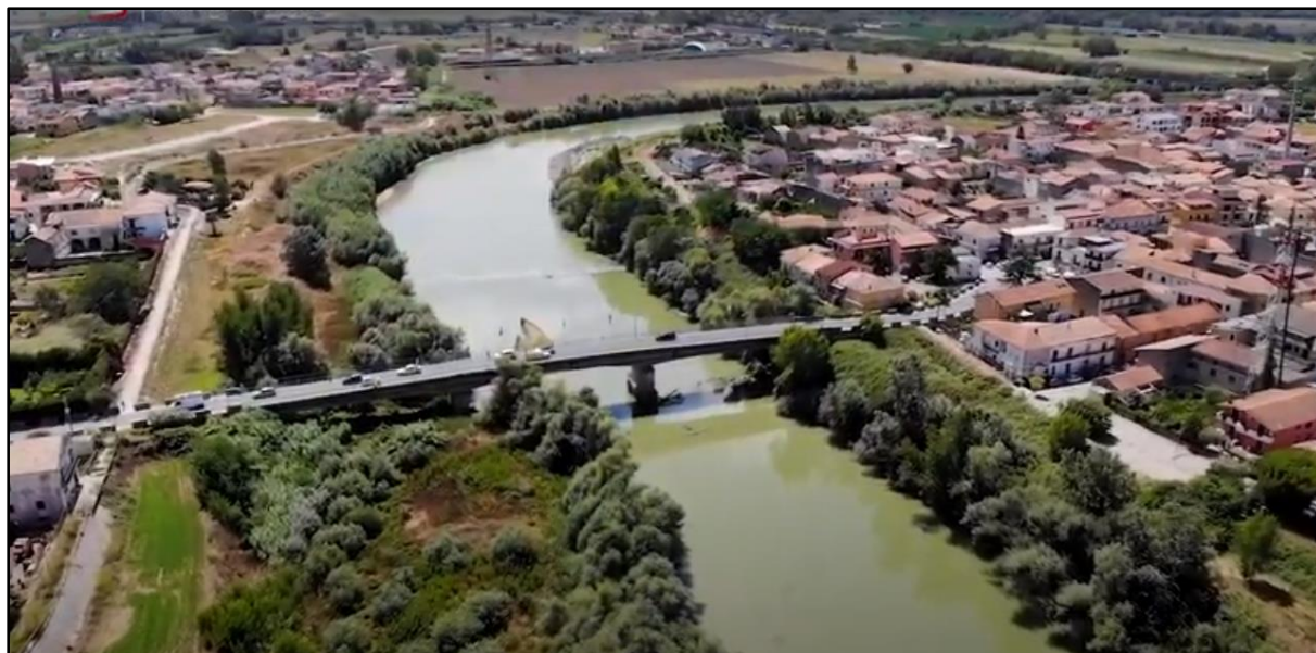
Fig. 1. Canello ed Arnone: ponte sul fiume Volturno.
