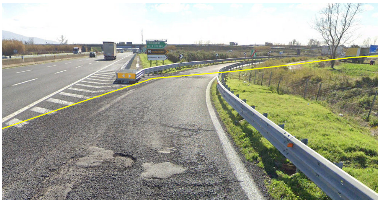
Figura 3: PUNTO 1 - Ingresso svincolo sulla SS7bis "Pomigliano-Villa Literno"
