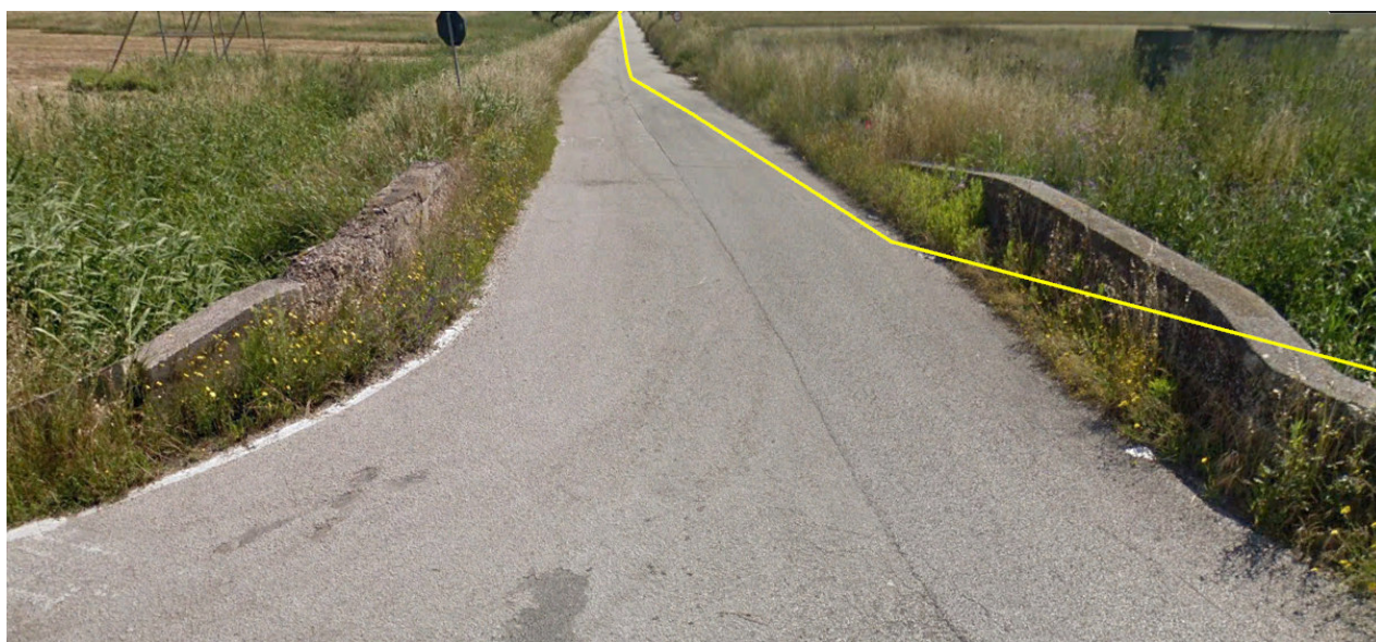
Figura 10: PUNTO 6 - Imbocco della Strada comunale in direzione Via Diaz Comune di Canello Arnone
