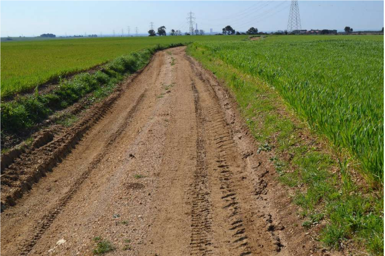
Fig. 27: Maccabove, sopralluogo: foto 12
