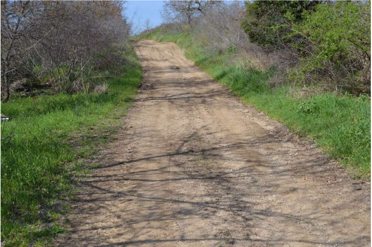
Fig. 33: strada dell'Abbadia, sopralluogo: foto 18
