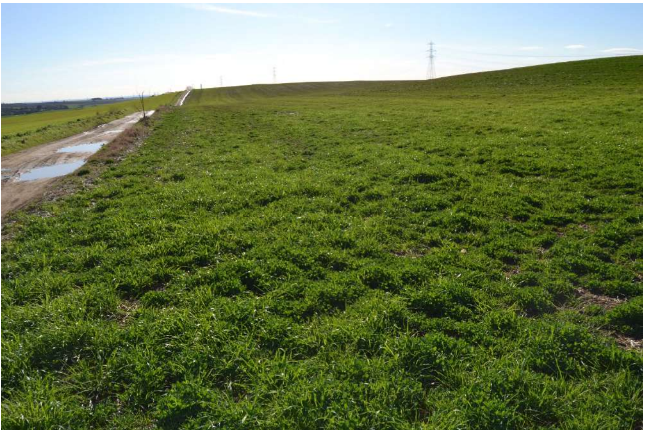
Fig. 16: Maccabove, sopralluogo: foto 2
