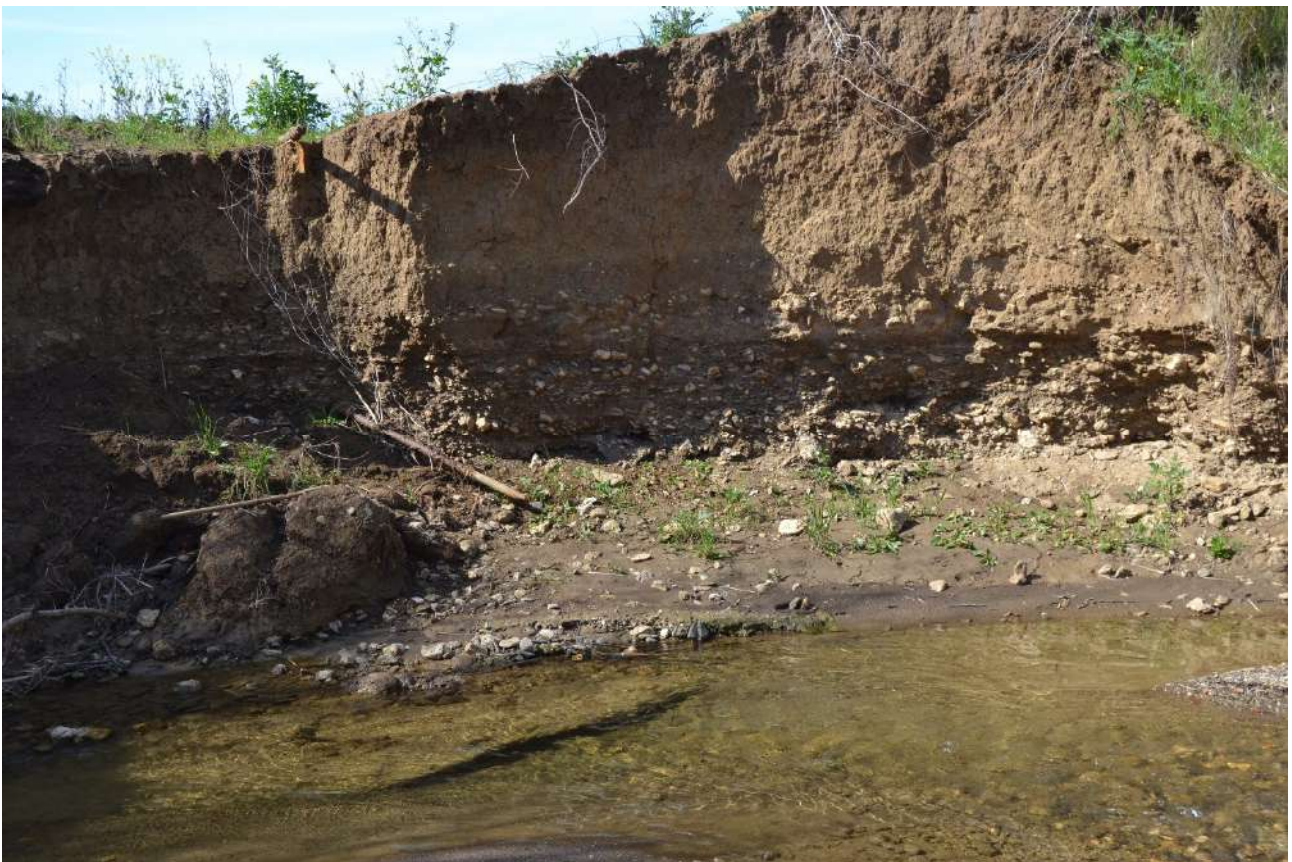
Fig. 32: strada dell'Abbadia, sopralluogo: foto 17: depositi alluvionali nel letto del Tafone
