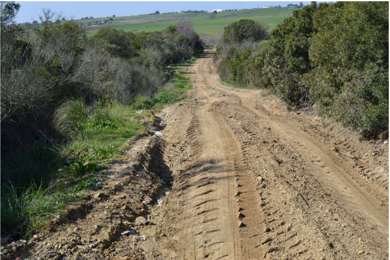
Fig. 34: sopralluogo: foto 23: strada dell'Abbadia
