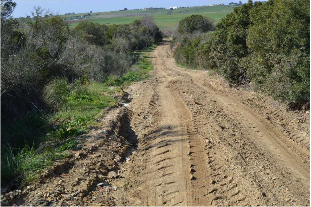
Fig. 29: strada dell'Abbadia, sopralluogo: foto 14
