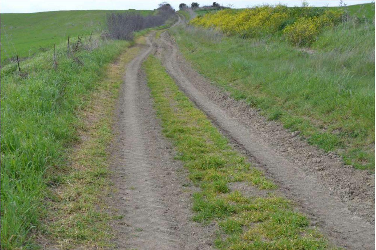
Fig. 35: strada dell'Abbadia, sopralluogo: foto 20
