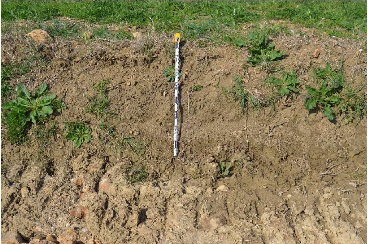
Fig. 25: Maccabove, sopralluogo: foto 10
