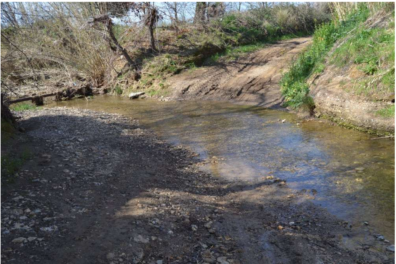
Fig. 32: sopralluogo: foto 21: attraversamento del torrente Tafone
