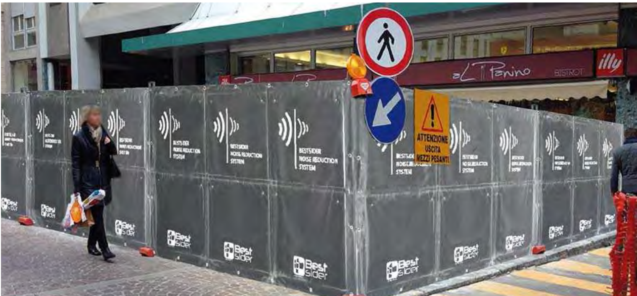
Figura 32. Esempio di Pannello antirumore mobile tipo Noise Control.
