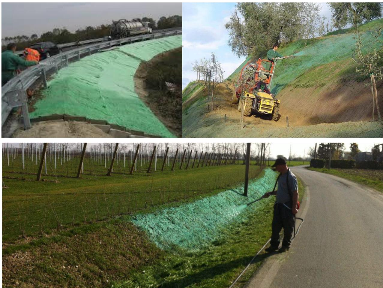
**Figura 31 – Tecniche di idrosemina**
