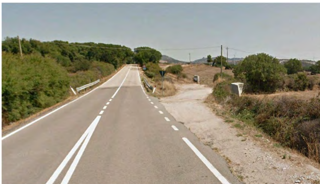
Figure 175 – Scatto fotografico lungo la strada esistente ove è previsto l'intervento di adeguamento in Direzione T06
