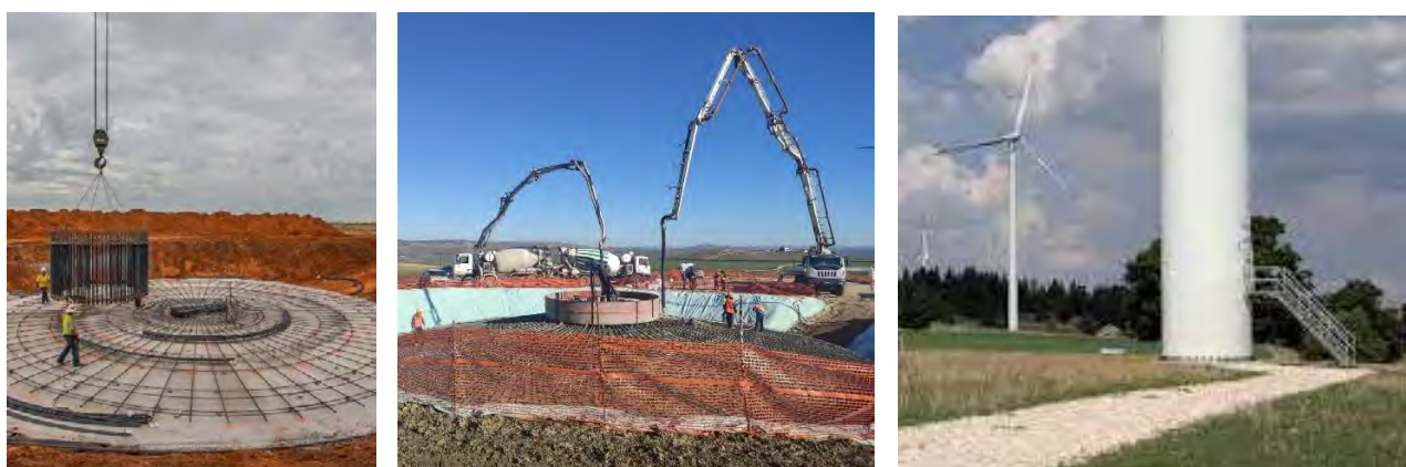
Figure 150 - Immagini tipo di alcune fasi di lavorazione della Fondazione degli aerogeneratori
