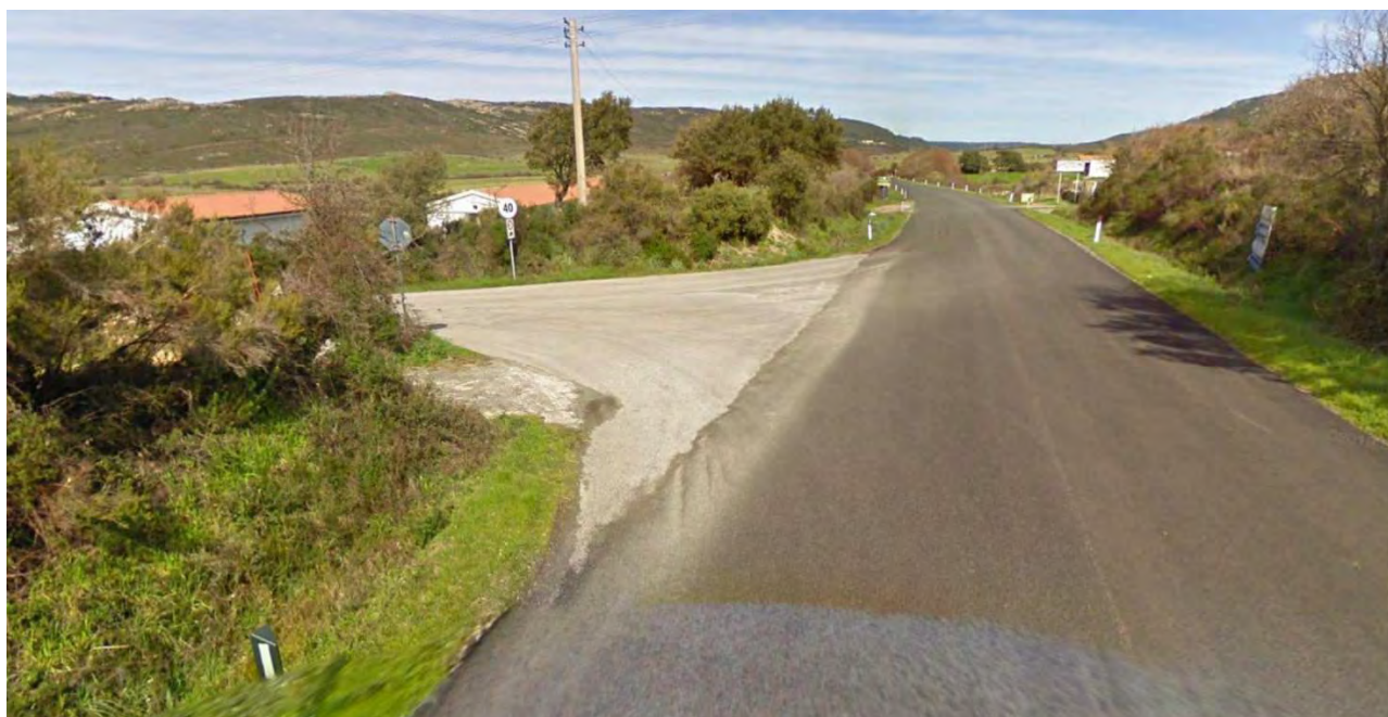
Figura 177 - Scatto fotografico lungo la strada esistente ove è previsto l'intervento di adeguamento in Direzione T02 e T10
