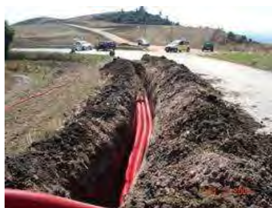
Figura 127 - Posa cavidotto MT tipo
