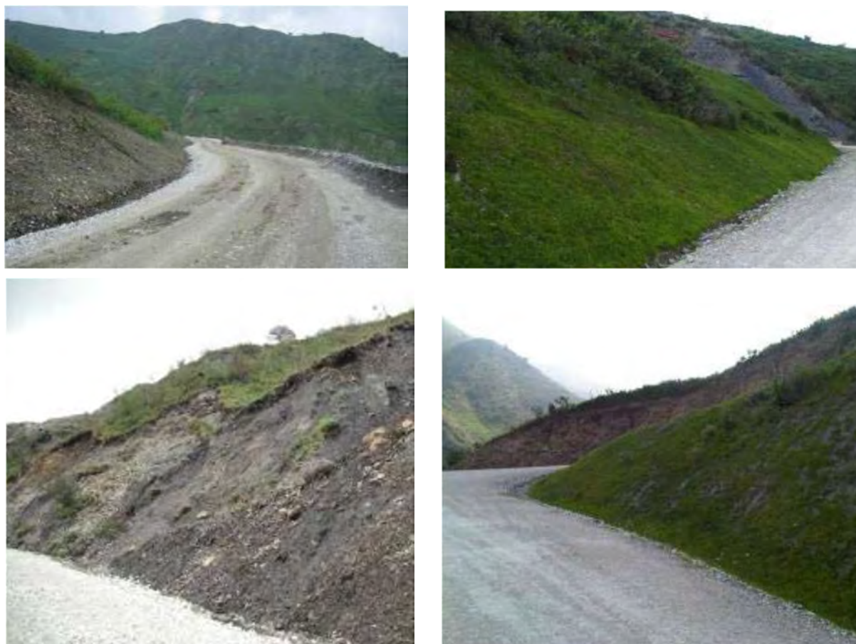
Figura 158 - Esempi di inerbimento post-operam delle scarpate oggetto di intervento, ove e se necessari
