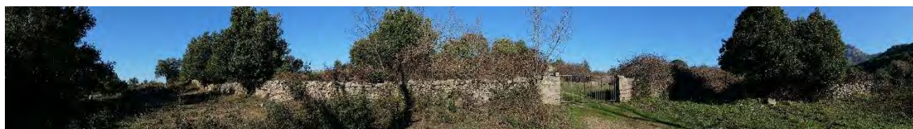
Stato di fatto del F333
