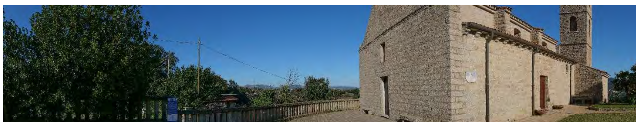
Stato di fatto del F265
