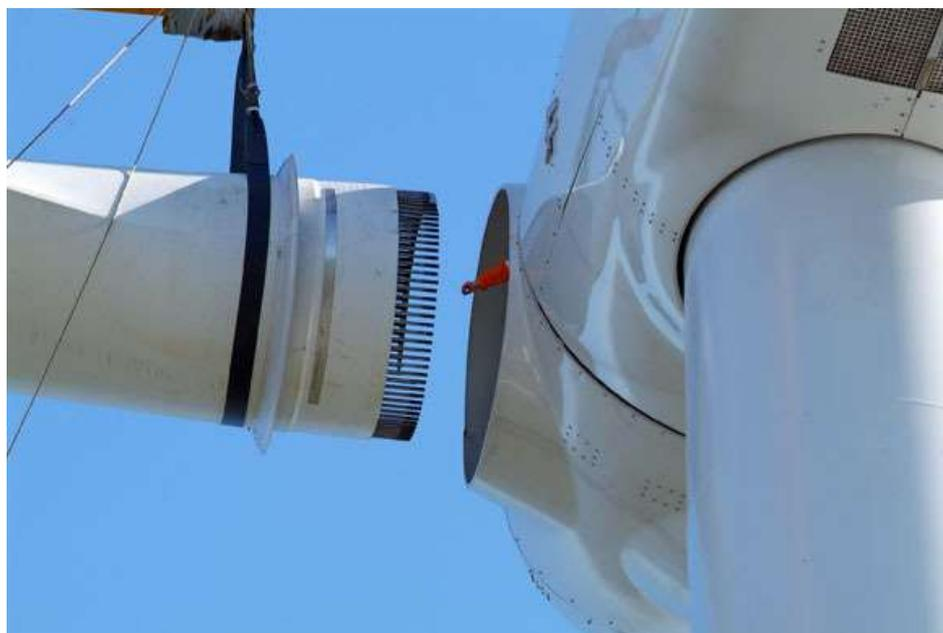
**Figura 2** Collegamento pala-mozzo
