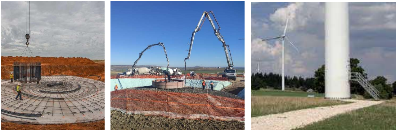
Figure 9 - Immagini tipo di alcune fasi di lavorazione della Fondazione degli aerogeneratori
