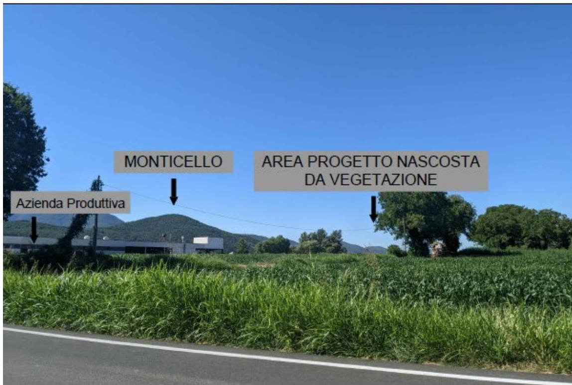
Figura 3: Foto 2 realizzata da Nord sulla Strada Provinciale n. 183 Pietramelara - Pantano
