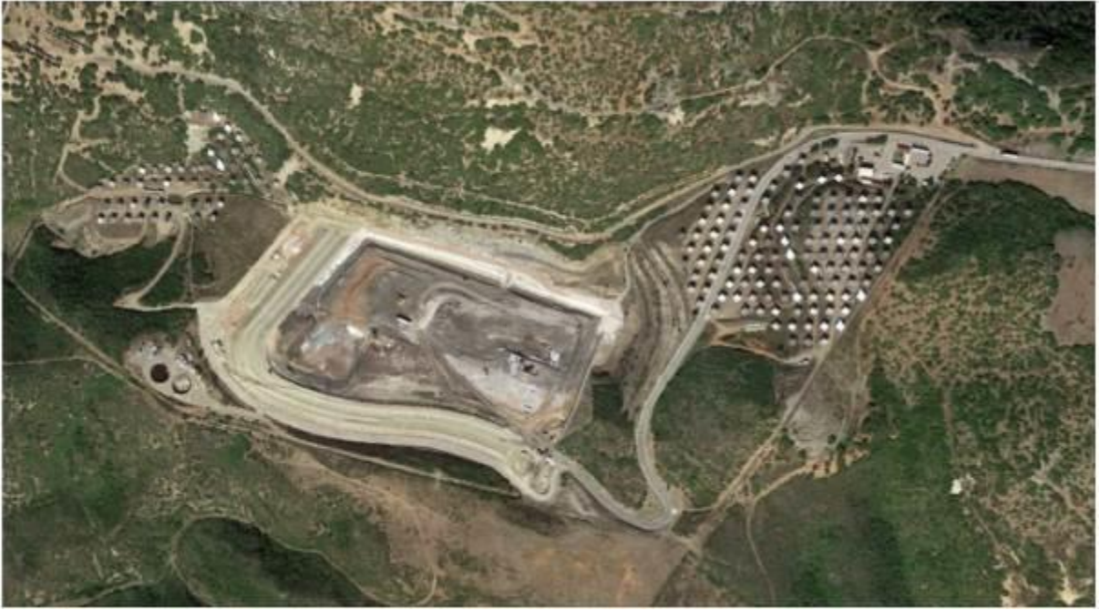
Figura 126 – impianto nel comune di Carbonia da 957,6 kw a 6 km di distanza
