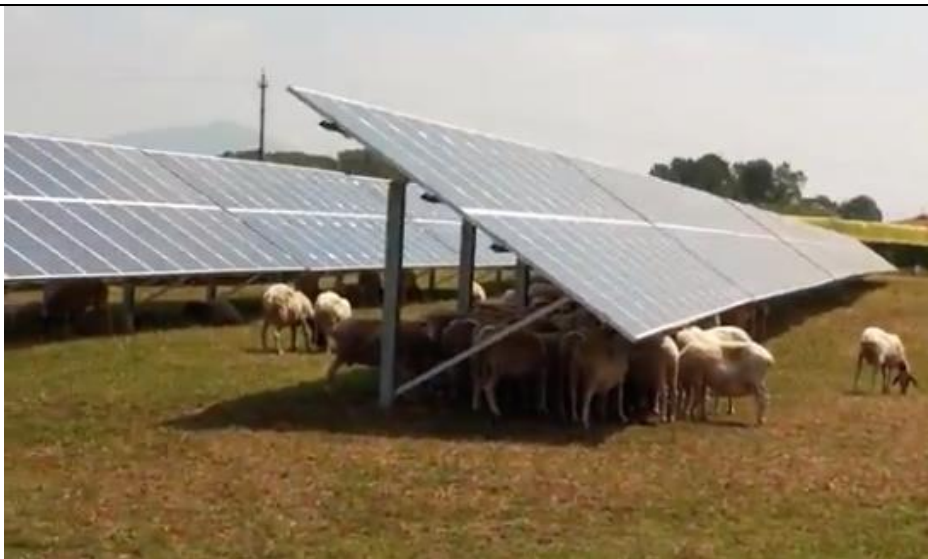
Figura 18 - Greggi di pecore come alternativa all'utilizzo di mezzi meccanici per il taglio dell'erba tra filari di moduli. Nella foto ripresa dal sito internet www.intellienergia.com , i sistemi di ancoraggio sono fissi, ma ovviamente nulla cambia nel caso di sistemi ad inseguimento.
