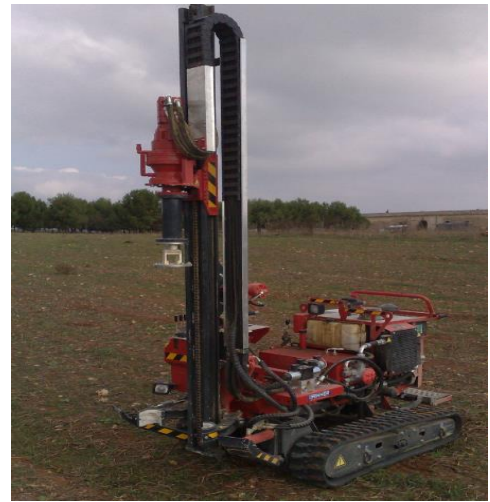
Macchina battipalo per infissione pali
