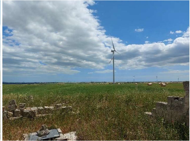
Foto n°8 - Vista generale pala eolica
