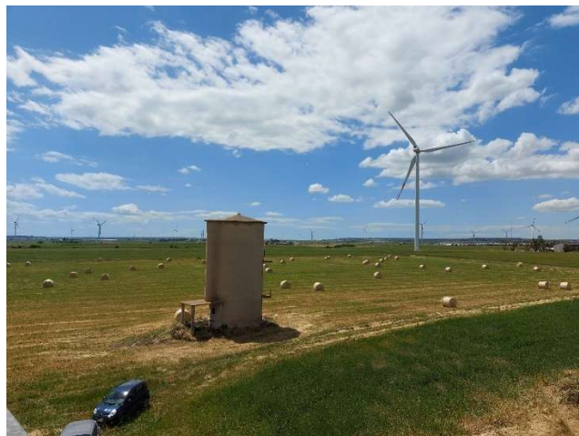
Foto n°14 - Vista generale impianto fotovoltaico
