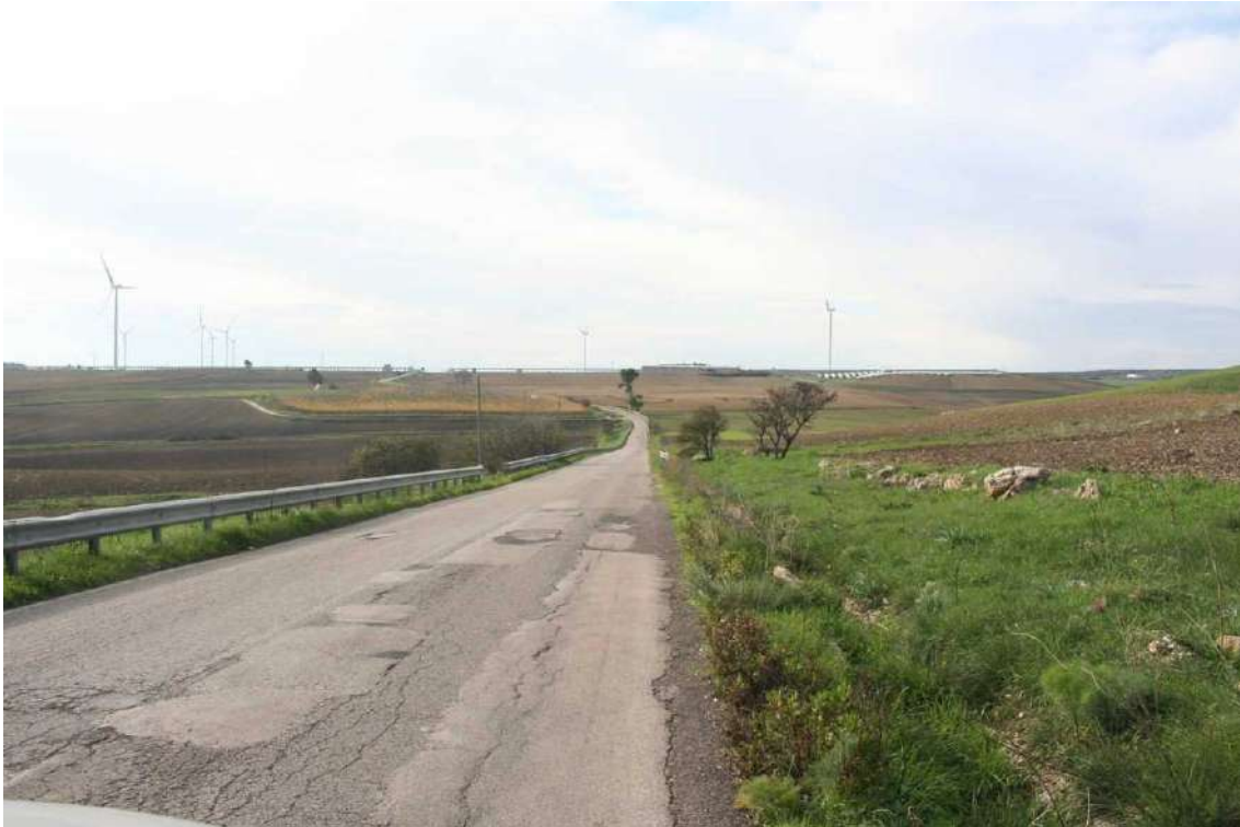
Fig.14 - Castellaneta (TA), panoramica in direzione O dell'UR 4, segmento di cavidotto corrente su SP 22
