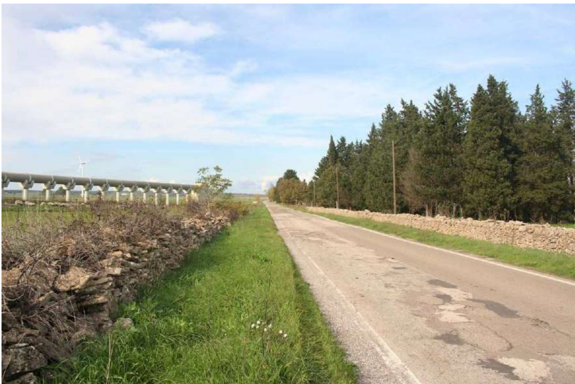
22 – Castellaneta (TA), loc. Tafuri UR 4 cavidotto: panoramica del segmento di cavidotto corrente su SP 21 in direzione N
