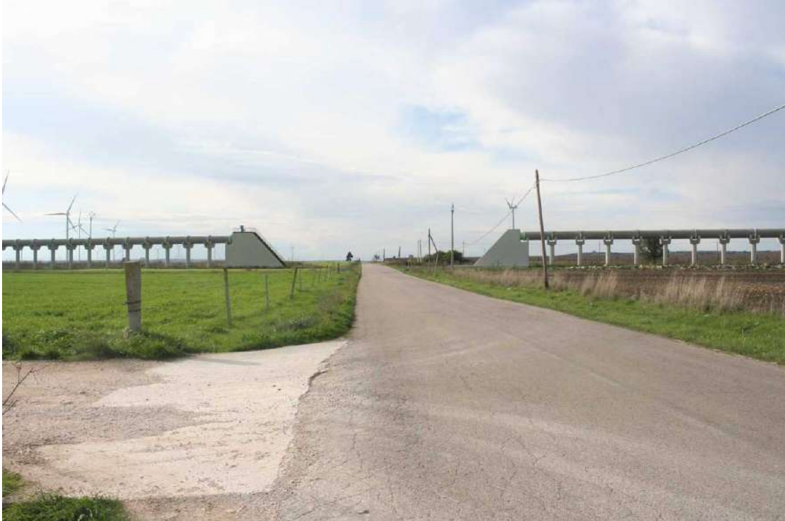
19 –Castellaneta (TA), loc. Tafuri UR 4 cavidotto: panoramica del segmento di cavidotto corrente su SP 22 in direzione O
