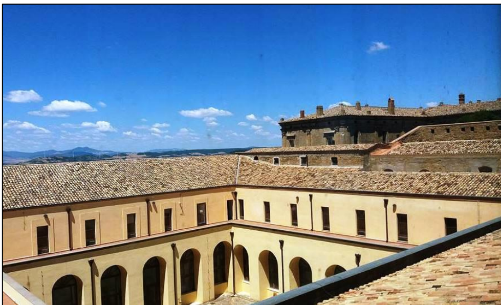
Figura 18 - Monastero di Santa Chiara (Fonte: sito ufficiale del comune di Ferrandina)
