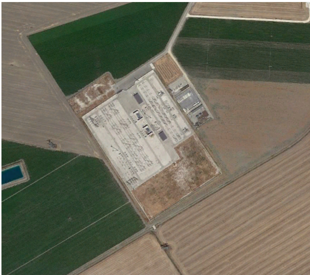
Figura 7: Sottostazione "Macchiarotonda" immagine del 2019
