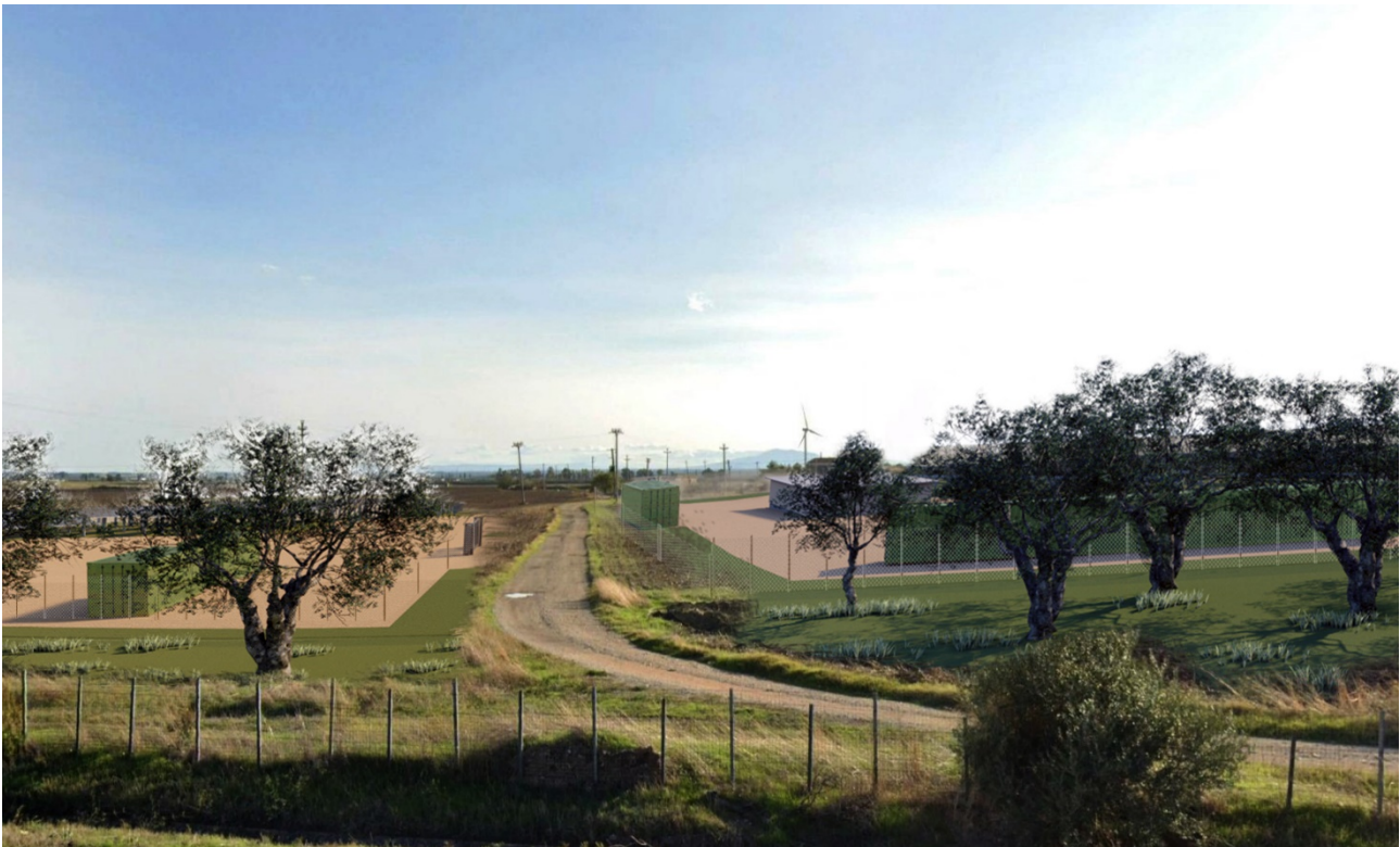
Figura 9 - Vista area ingresso impianto (fotoinserimento)
