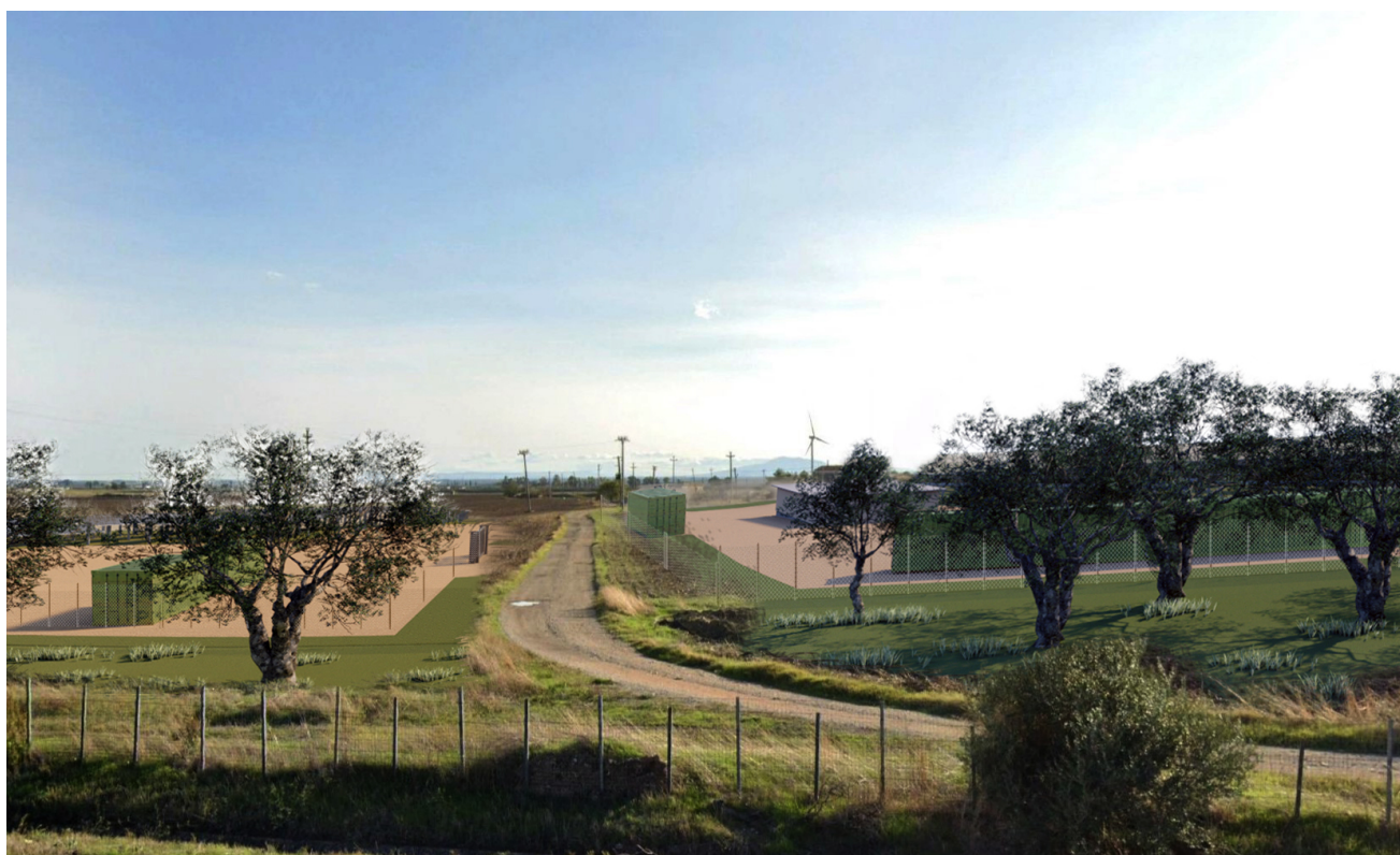
Figura 35 - Vista area ingresso impianto (fotoinserimento)
