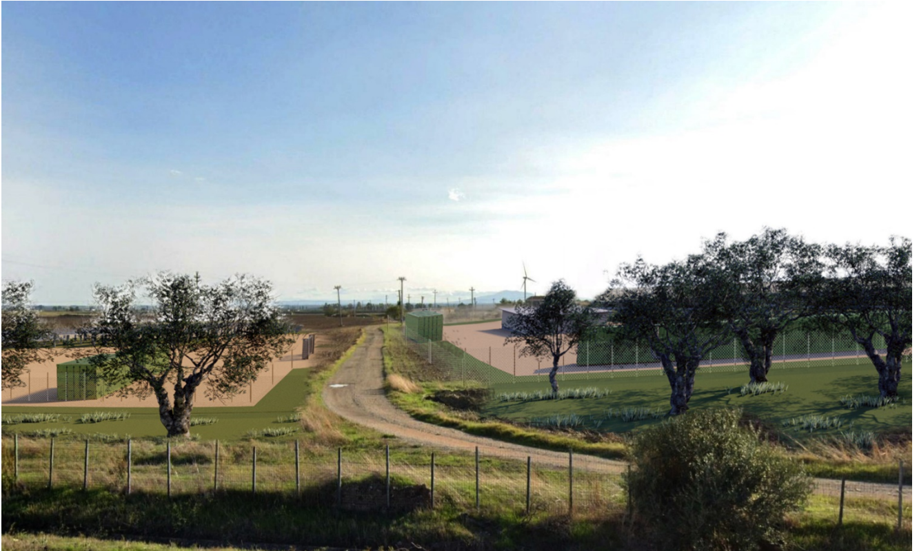
Figura 35 – Fotoinserimento Vista area ingresso impianto
