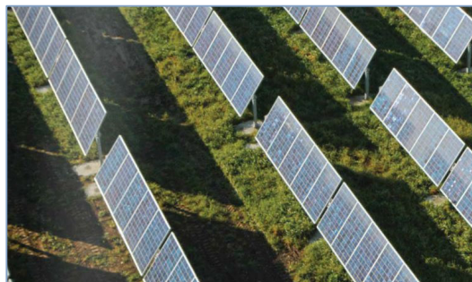
Fig. 1 trackers ad asse variabile
