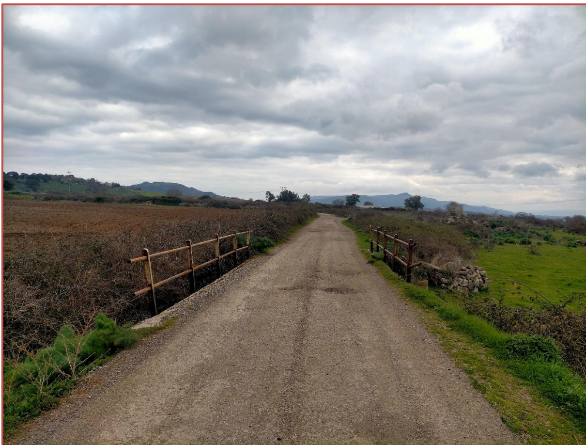
FIGURA 19 – Punto di intersezione tra il cavidotto in progetto (strada) e il Riu Mene.
