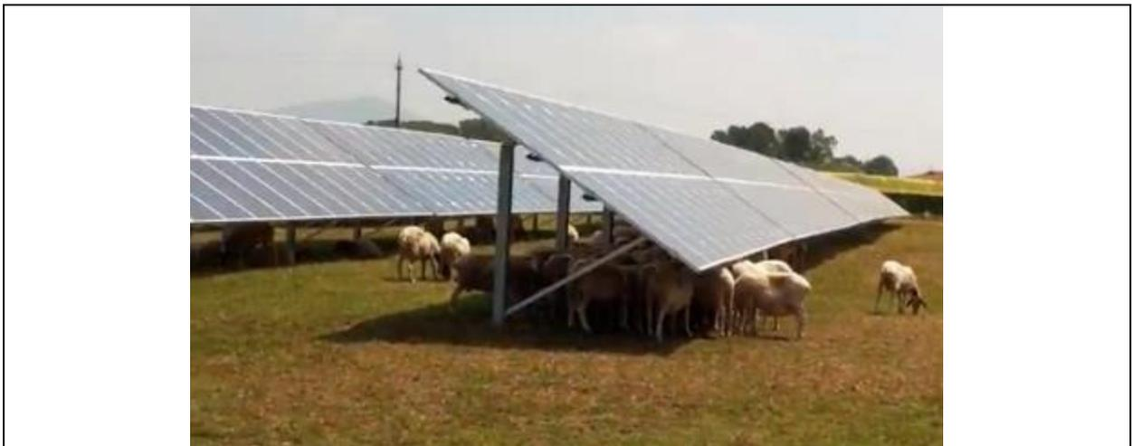
Figura 92 - Greggi di pecore come alternativa all'utilizzo di mezzi meccanici per il taglio dell'erba tra filari di moduli. Nella foto ripresa dal sito internet [www.intellienergia.com](http://www.intellienergia.com), i sistemi di ancoraggio sono fissi, ma ovviamente nulla cambia nel caso di sistemi ad inseguimento.
