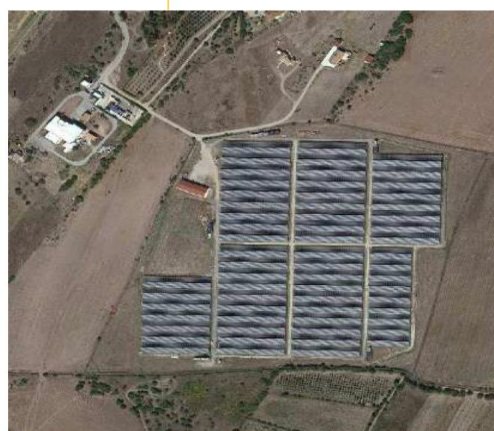
IMPIANTO SANTADI 4962 KW A 1,6 KM DI DISTANZA
