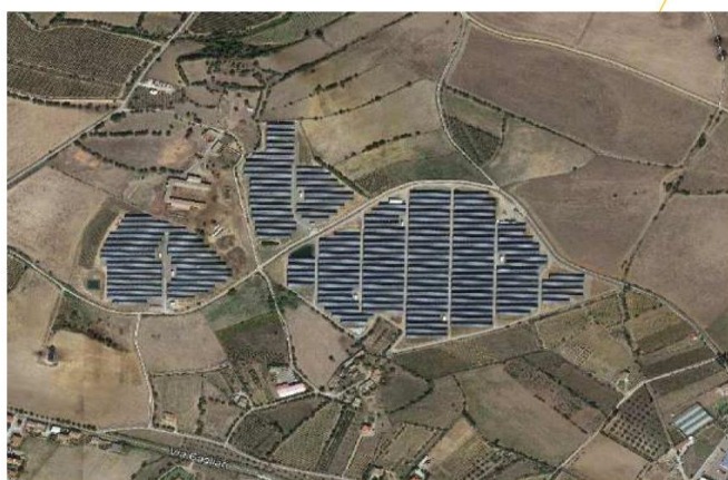
IMPIANTO VILLAPERUCCIO 5980,92 KW A 2,8 KM DI DISTANZA
