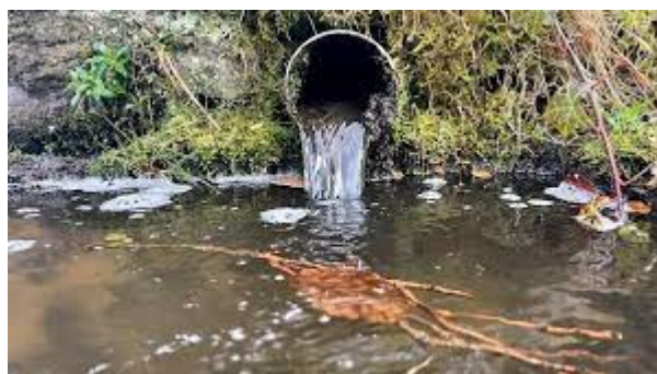
Figura 26 - esempio di culvert pipe
