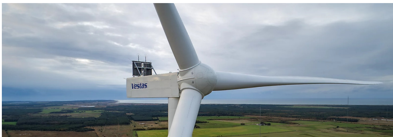
Figura 8 - vista in quota navicella e rotore aerogeneratore da 6 MW
