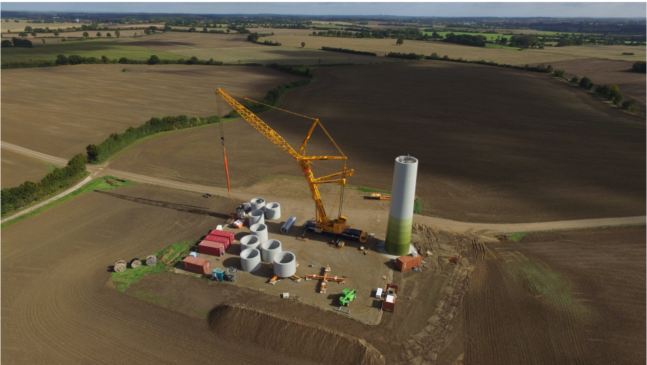
Figura 4 - vista piazzola durante le attività di montaggio
