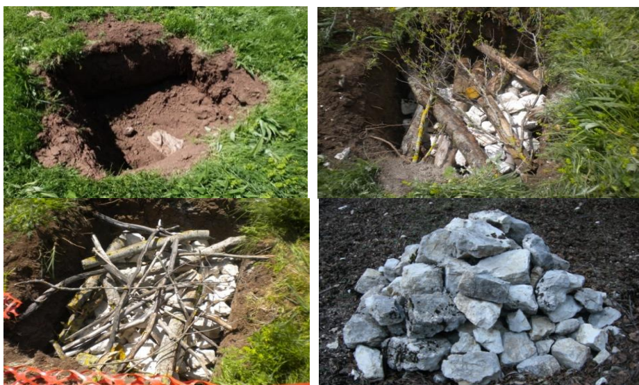
Figura 43. Le diverse fasi di realizzazione di un rifugio interrato anti-fuoco per piccoli animali terricoli. Si tratta di una delle mitigazioni più efficaci per ridurre l'inutile distruzione della biodiversità a causa degli abbruciamenti annuali della vegetazione ruderale o infestante.
