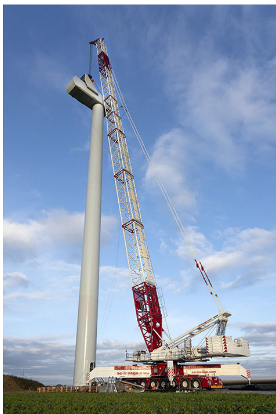
Figura 19 – Una gru tipo Liebherr 1750 durante l'installazione di un generatore eolico
