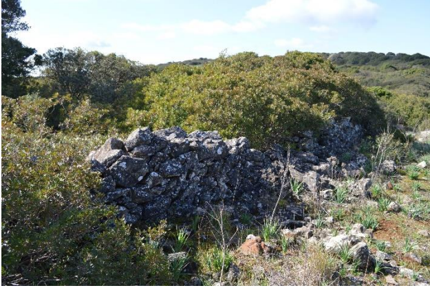
Figura 78 - Muretto a secco in stato di abbandono nell'area interposta tra il sito di realizzazione dell'aerogeneratore WTG_08 e WTG_09
