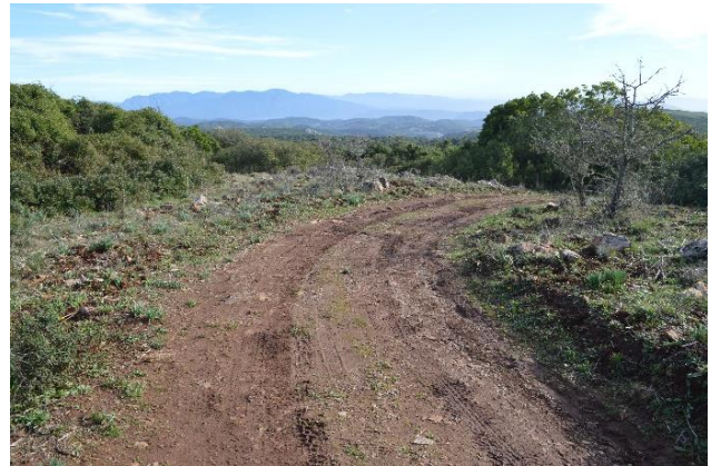
Figura 58 – Tratturo di collegamento tra la WTG_01 e WTG_02
