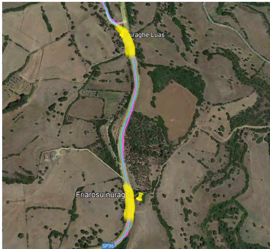
Fig. 55: Mogorella, 1° tratta elettrodotto interrato: il tracciato in progetto, segnato in celeste e, in giallo, l'indicazione delle porzioni valutate a medio rischio archeologico.
