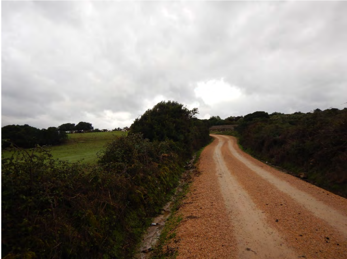
Fig. 74: Mogorella: tracciato stradale, sud di M02, interessato dall'elettrodotta interrato in progetto.
