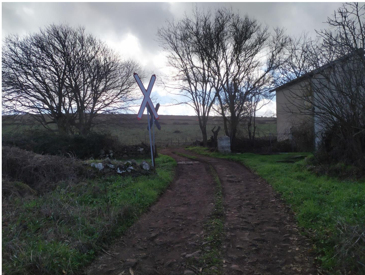
Figura 14: Vista dell'intersezione tra la nuova viabilità e la ferrovia dismessa
