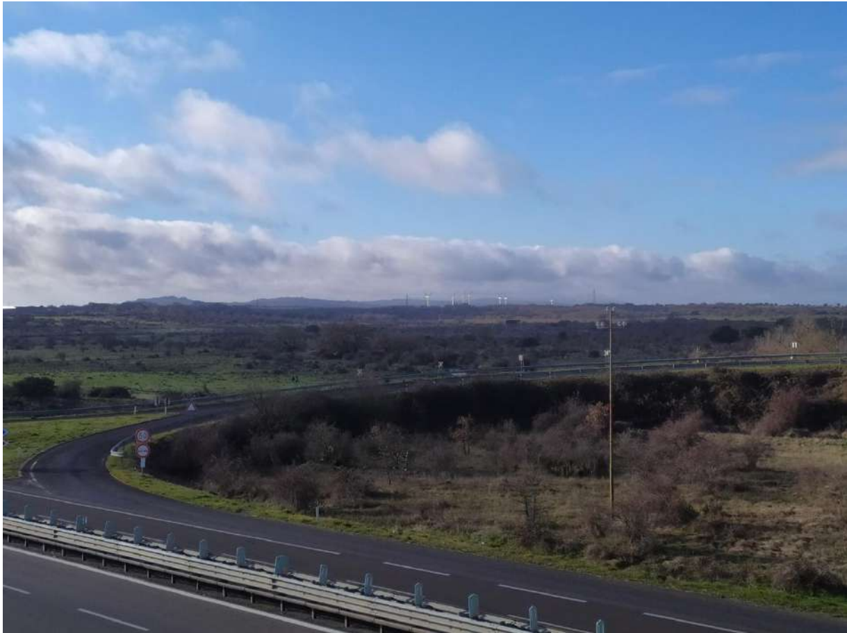
Figura 160: Post-operam: Visuale del Punto di ripresa PV28 verso le WTG di progetto (Coordinate: 481741.00 m E, 4467089.00 m N).
