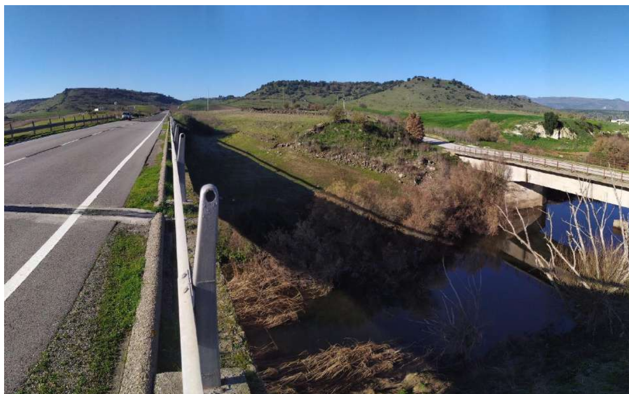
Figura 105: Ante-operam: Visuale del Punto di ripresa PV10 verso le WTG di progetto (Coordinate: 495770.00 m E, 4453173.00 m N).
