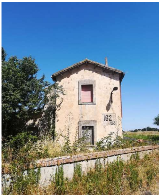
Figura 68: Casa Cantoniera km 162 533, id bene: 3200117, Comune di Macomer.
