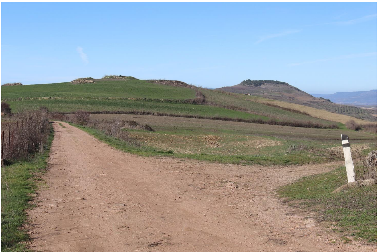
Figura 8.16 – Innesso della viabilità di collegamento alla postazione SE01 sulla esistente viabilità comunale (vista verso ovest)
