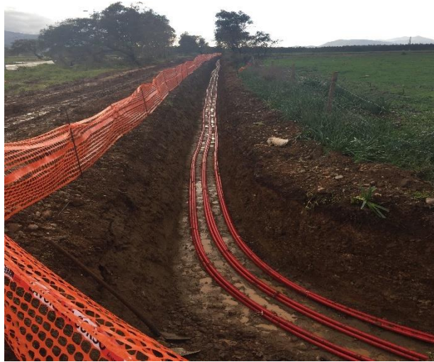
Figura 9.1 - Posa cavidotti parco del Guspinese
