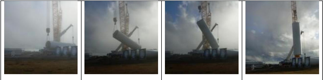
Figura 8.26 – Schema delle fasi di sollevamento dei componenti dell'aerogeneratore (Fonte sito web http://www.windfarmbop.com/ )
