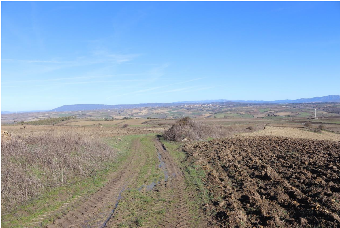
Figura 8.11 – Esistente tratturo oggetto di adeguamento in prossimità della postazione SE05 (vista verso nord)
