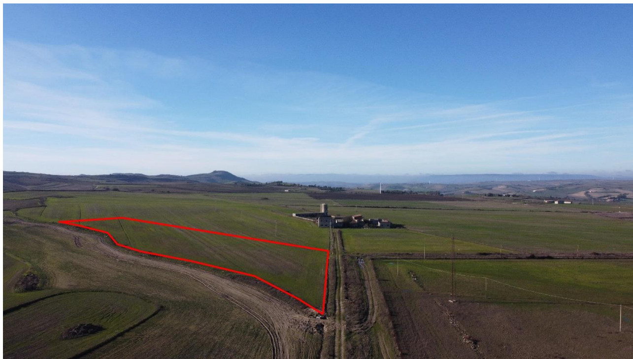
Figura 7.3 – Sito individuato per l’allestimento delle aree di trasbordo e cantiere di base in comune di Selegas (vista aerea da est). In secondo piano gli edifici del complesso agricolo Fattoria S. Maria
