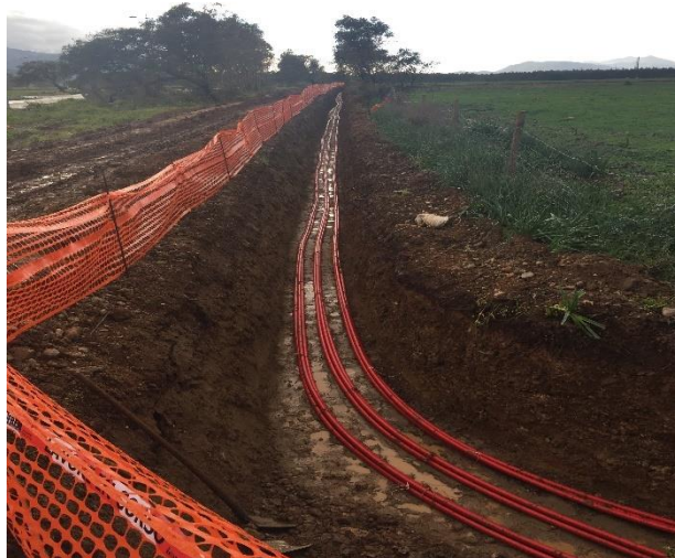
Figura 6.4 - Posa cavidotti parco del Guspinese
