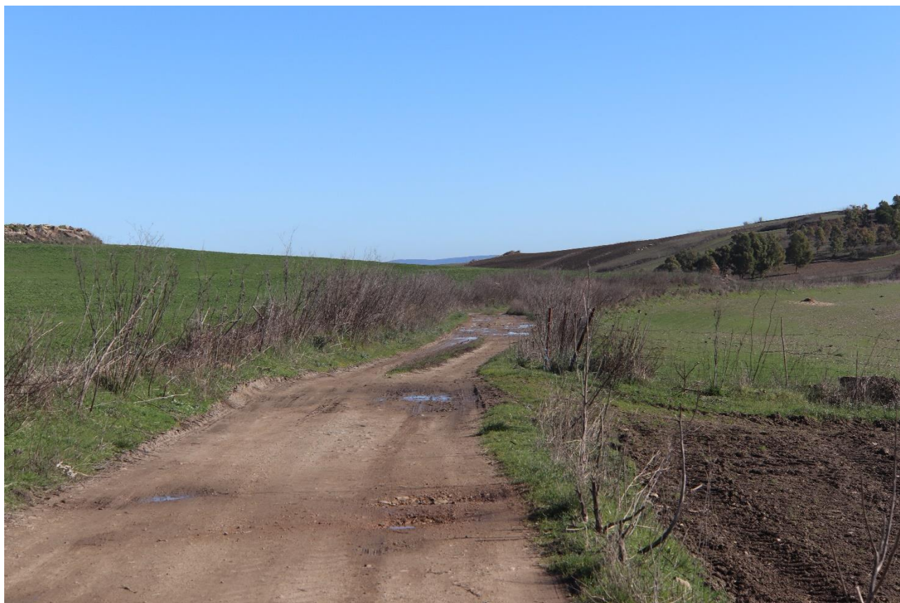
Figura 5.18 – Esistente strada interpodereale da adeguare per il collegamento della postazione eolica SE02 (vista verso est)
