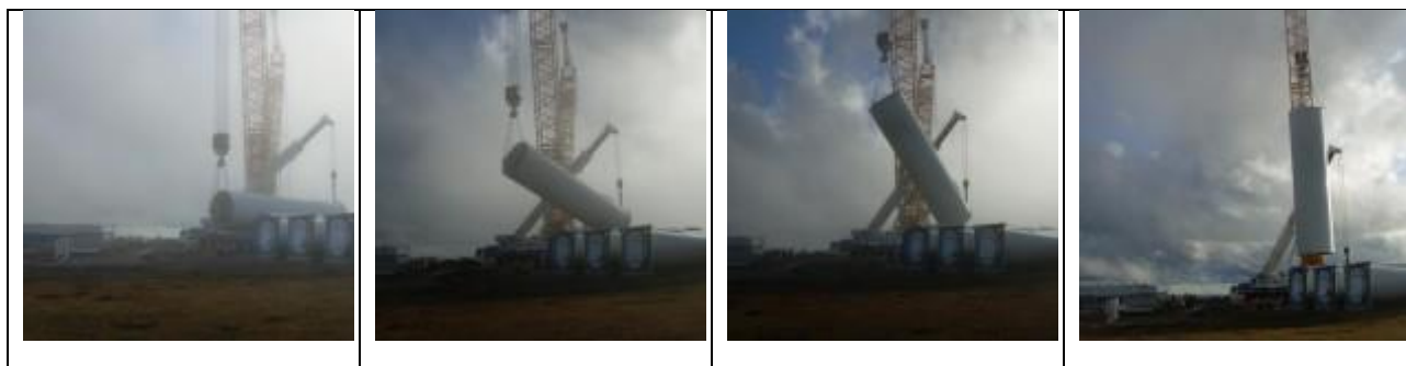
Figura 5.26 – Schema delle fasi di sollevamento dei componenti dell'aerogeneratore (Fonte sito web http://www.windfarmbop.com/ )
