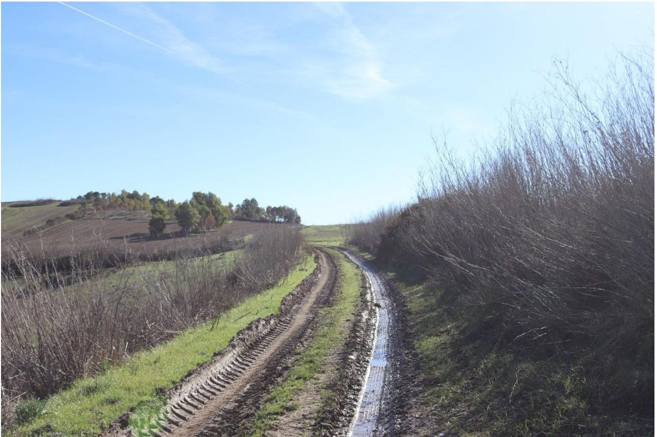
Figura 17 – Esistente viabilità di collegamento della postazione SE01 oggetto di adeguamento funzionale (vista verso sudest)
