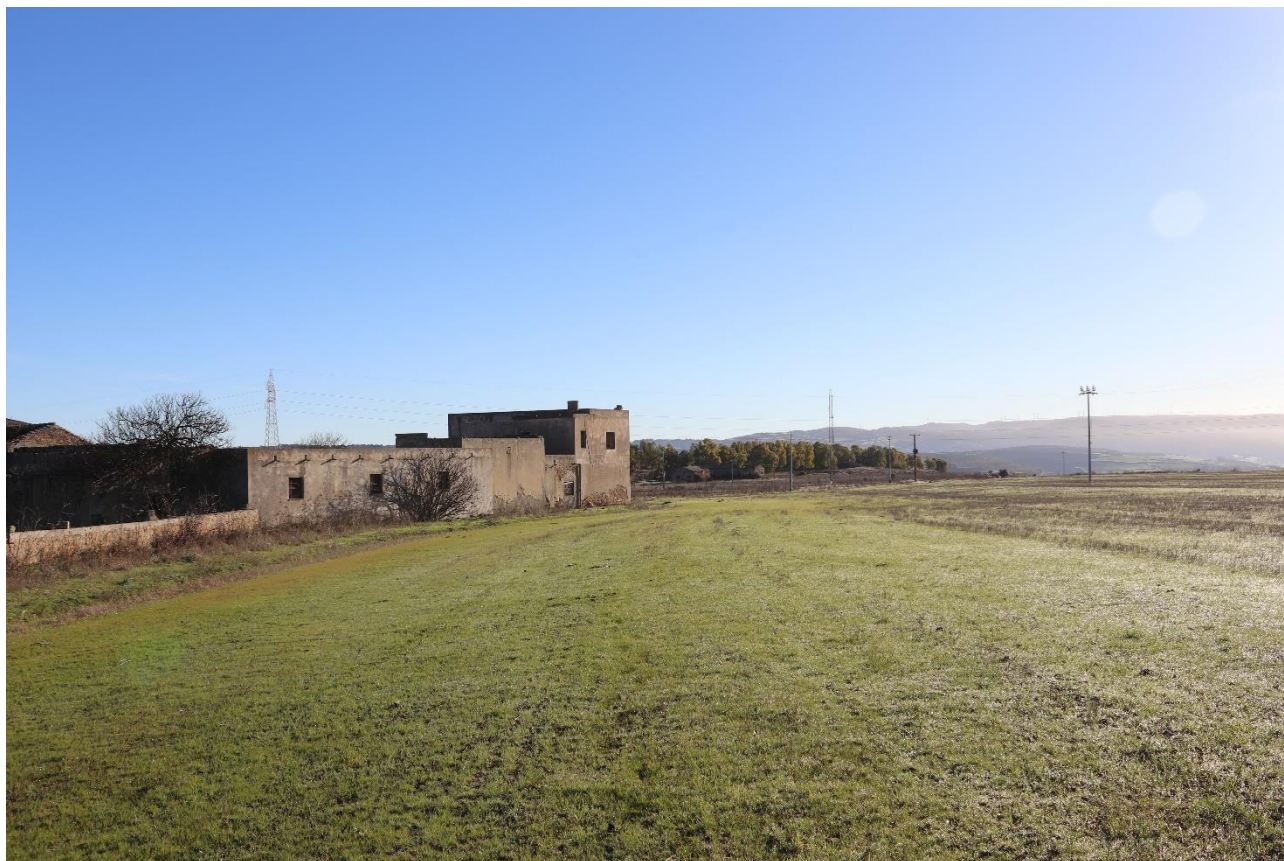
Figura 5.6 – Terreni attraversati dal nuovo tratto di viabilità nei pressi della loc. Fattoria S. Maria (vista verso SE)
