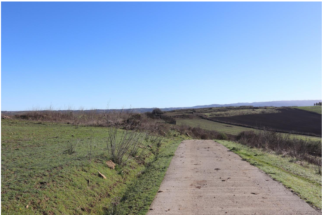
Figura 8 – Esistente strada cementata in prossimità della postazione SE06 facente parte della viabilità di
