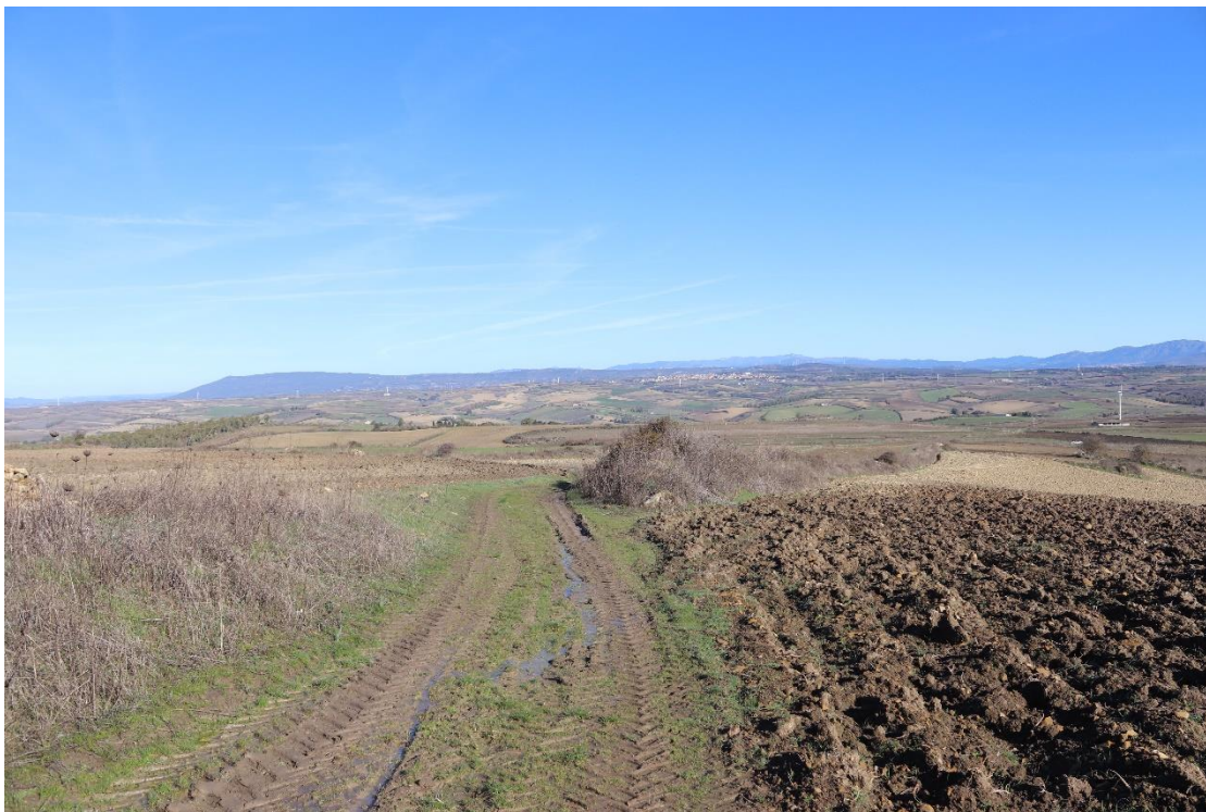
Figura 5.11 – Esistente tratturo oggetto di adeguamento in prossimità della postazione SE05 (vista verso nord)
