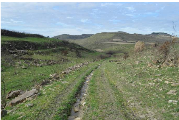
Figura 4.38 - Tratturo interessato dalla posa del cavidotto. In secondo piano: complesso collinare della località Crabilis
