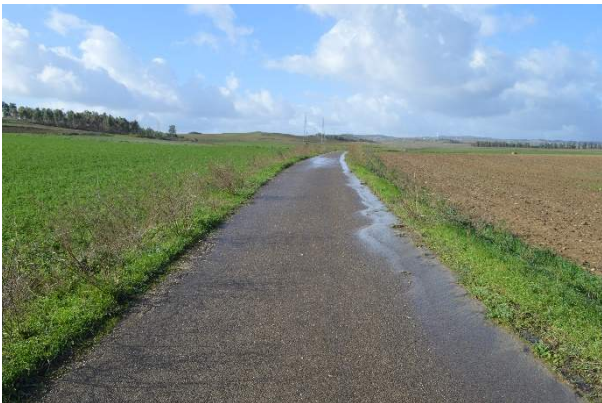
Figura 4.42 - Tratto asfaltato interessato dalla posa del cavidotto MT in comune di Furtei
