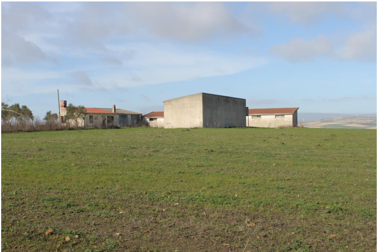
Figura 6.1 – Edificio F18 (vista da sudest)
