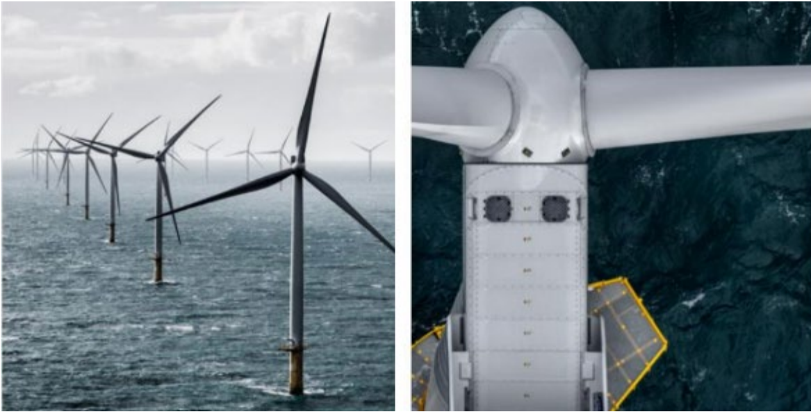
Figura 3: Esempio Aerogeneratore Vestas V236-15.0 MW
