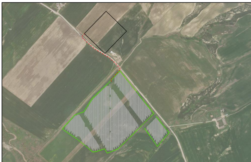
Figura 35 – Barriera a verde perimetrale
