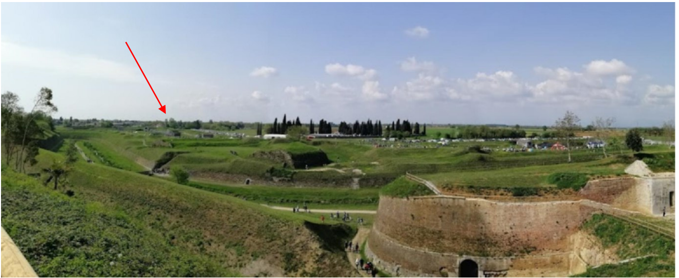
Punto di scatto n°6 . Panoramica eseguito dal percorso turistico “anello del Rivellino” dal belvedere delle Fortificazioni in direzione dell’area di intervento che non risulta visibile
