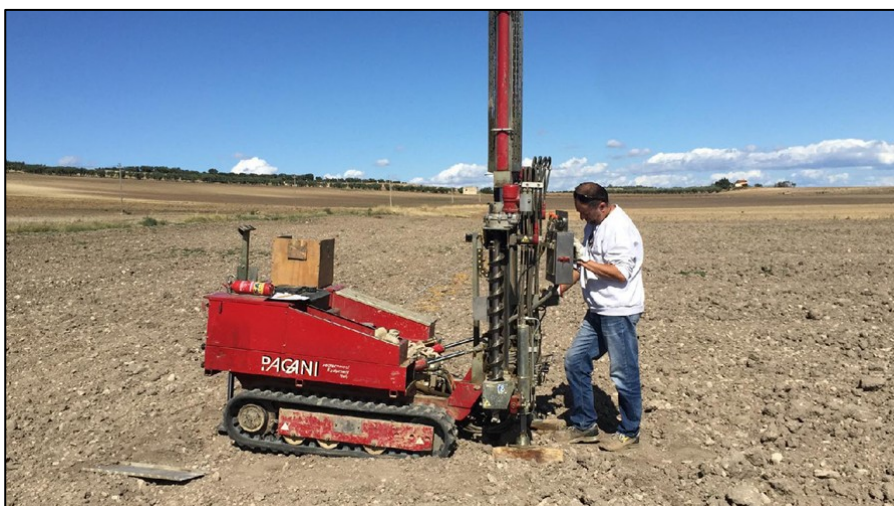
Figura 11 – Foto dell’esecuzione delle prove penetrometriche DPSH1 (in alto), DPSH2 (al centro) e DPSH3 (in basso).
