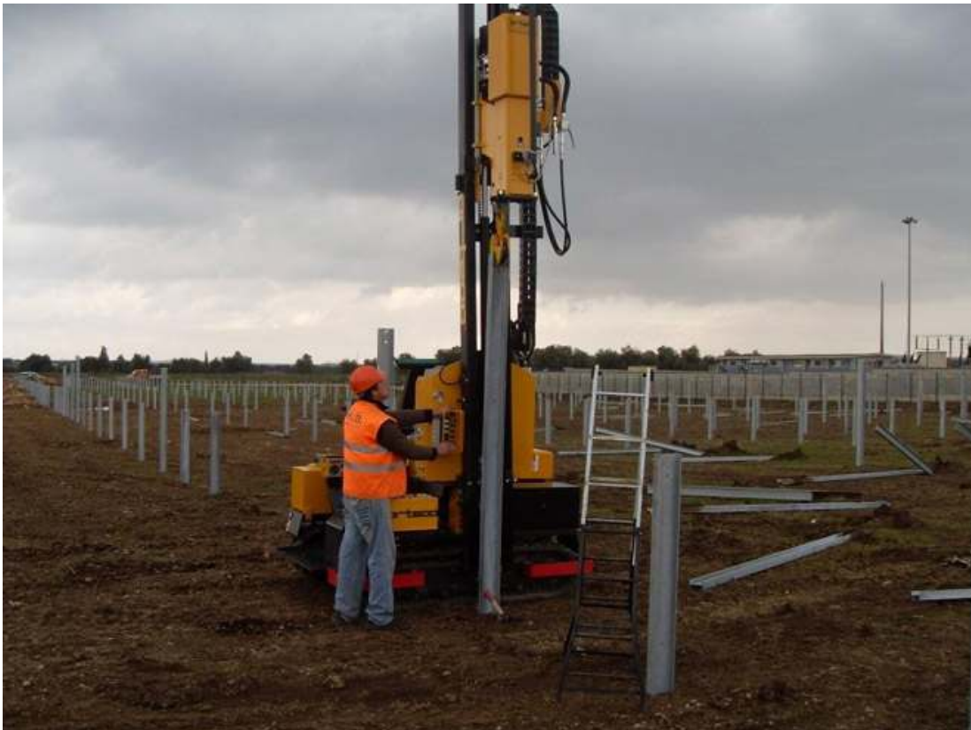
Fig.°58 Operazione di rimozione dei pali infissi
