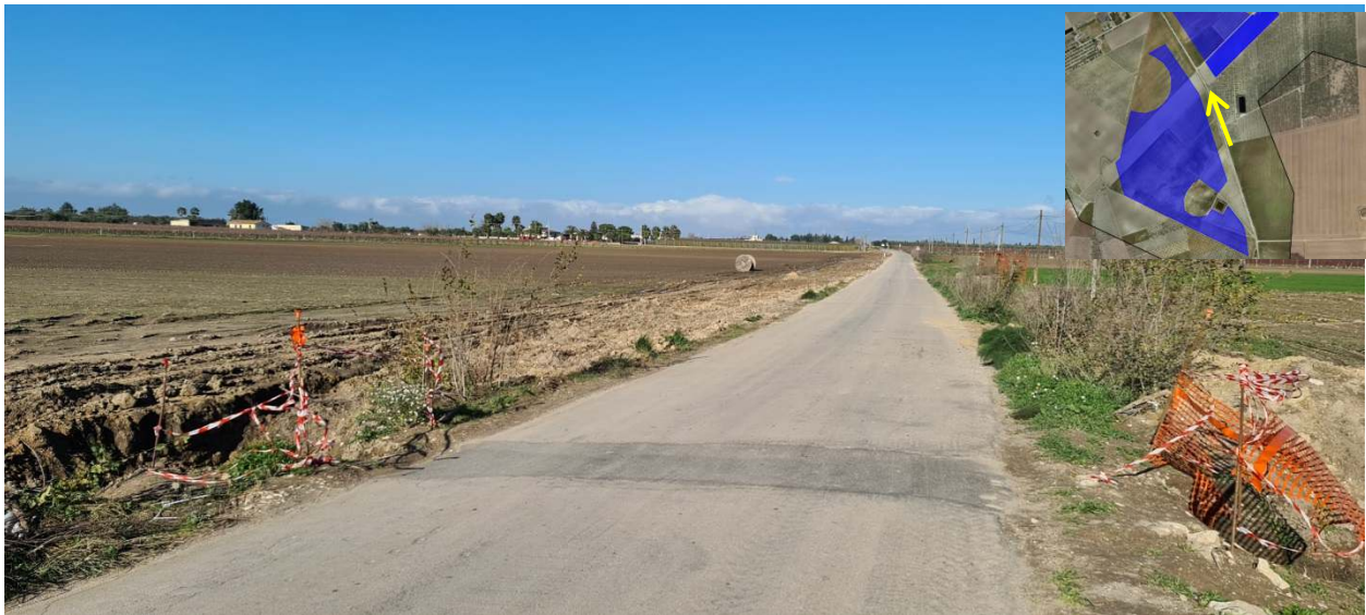
Fig. n.53 Foto interferenza elettrodotto con altri cavi MT interrati
