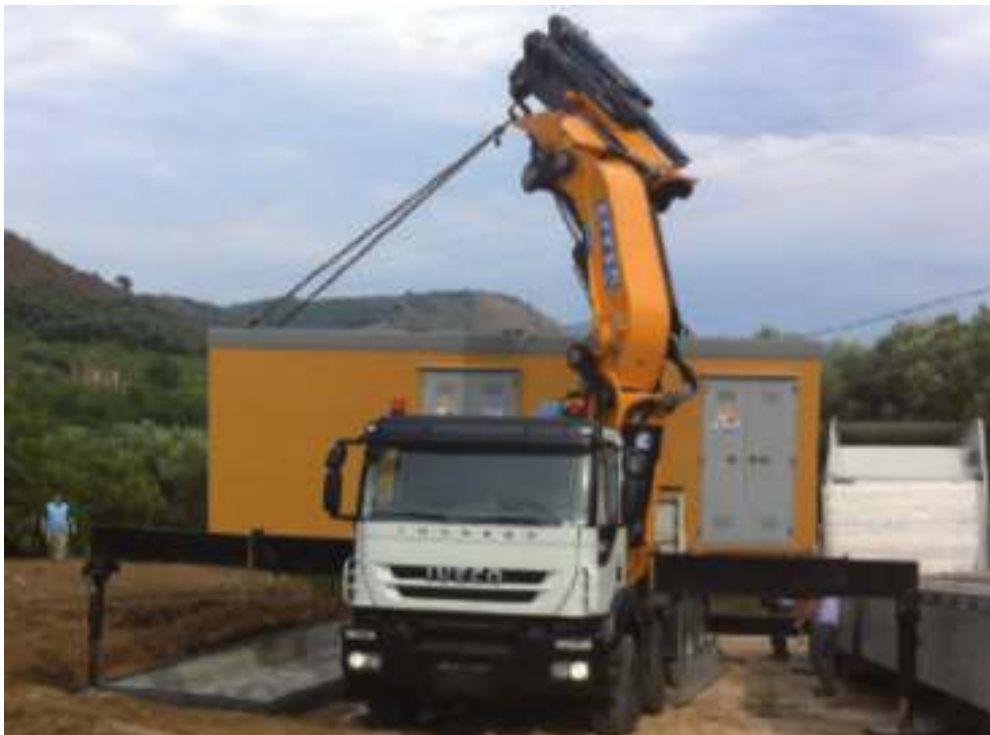
Fig. 59 Operazione di rimozione delle cabine prefabbricate
