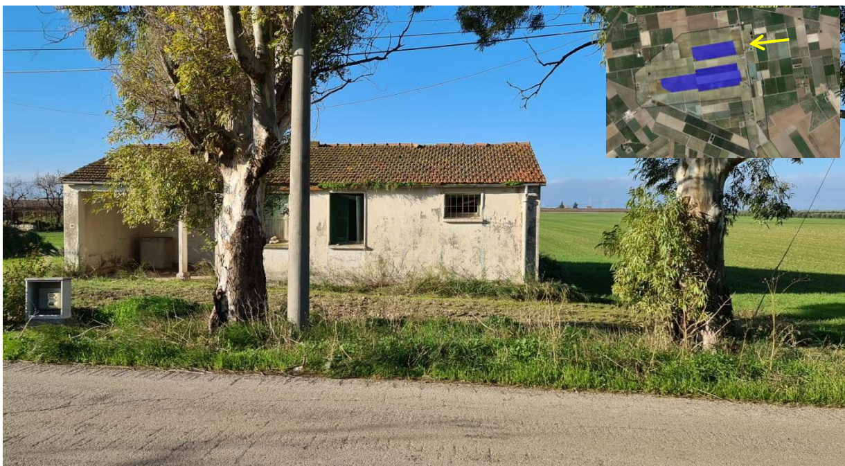
Fig 12 Foto fabbricato rurale diruto "Blocco A"
