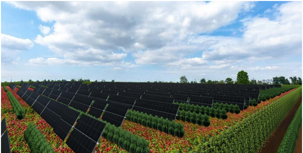
Fig. 6 Rendering dell'impianto agrivoltaico con oliveto e essenze foraggiere azoto fissatrici
