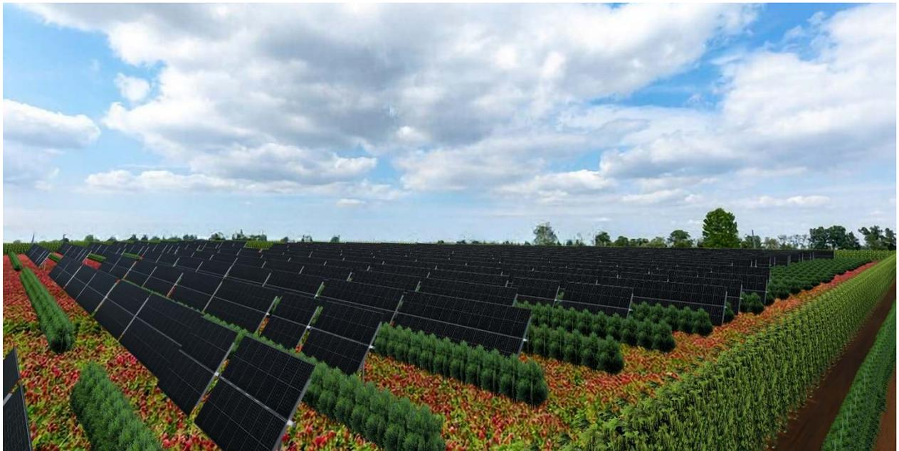
Fig. 14 Rendering dell'impianto agrivoltaico con oliveto e essenze foraggiere azoto fissatrici
