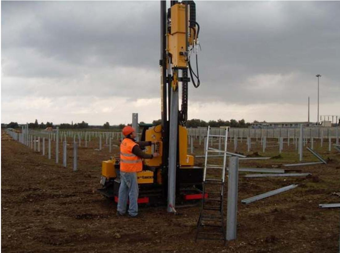
Fig.°23 Operazione di rimozione dei pali infissi
