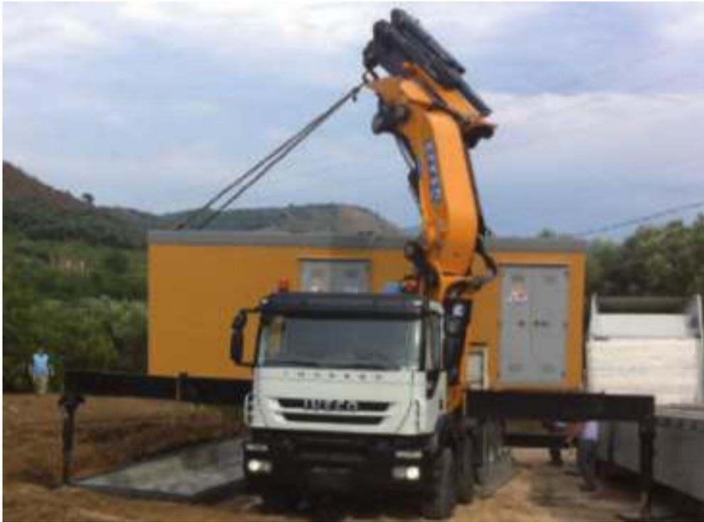
Fig. 24 Operazione di rimozione delle cabine prefabbricate
