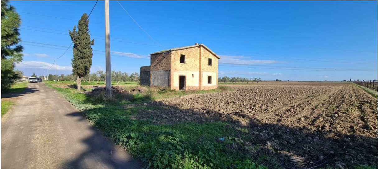
Figura 1-19: CER01_V_21 - Vista verso blocchi A e B: ante-operam
