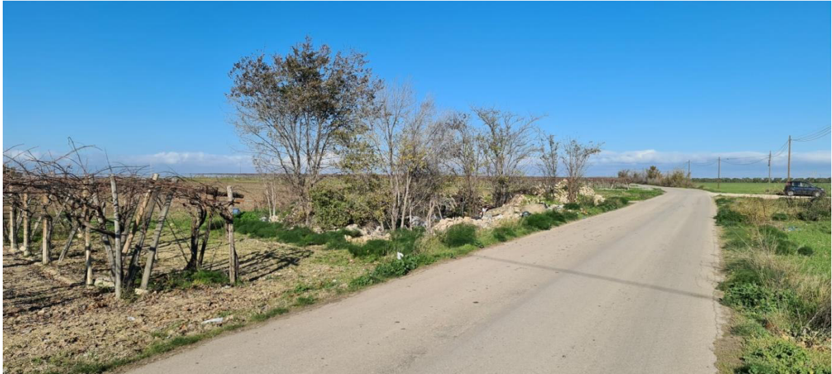
Figura 1-27: CER01_V_26 – vista verso blocco F: ante-operam
