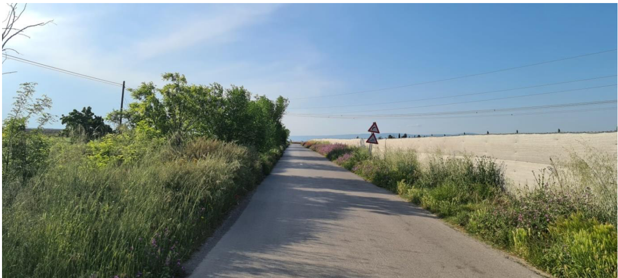
Figura 1-68: Alcune vedute - punto di presa CER01_NV_12 - Masseria Campanello - verso blocchi A e B – S.P. 69
