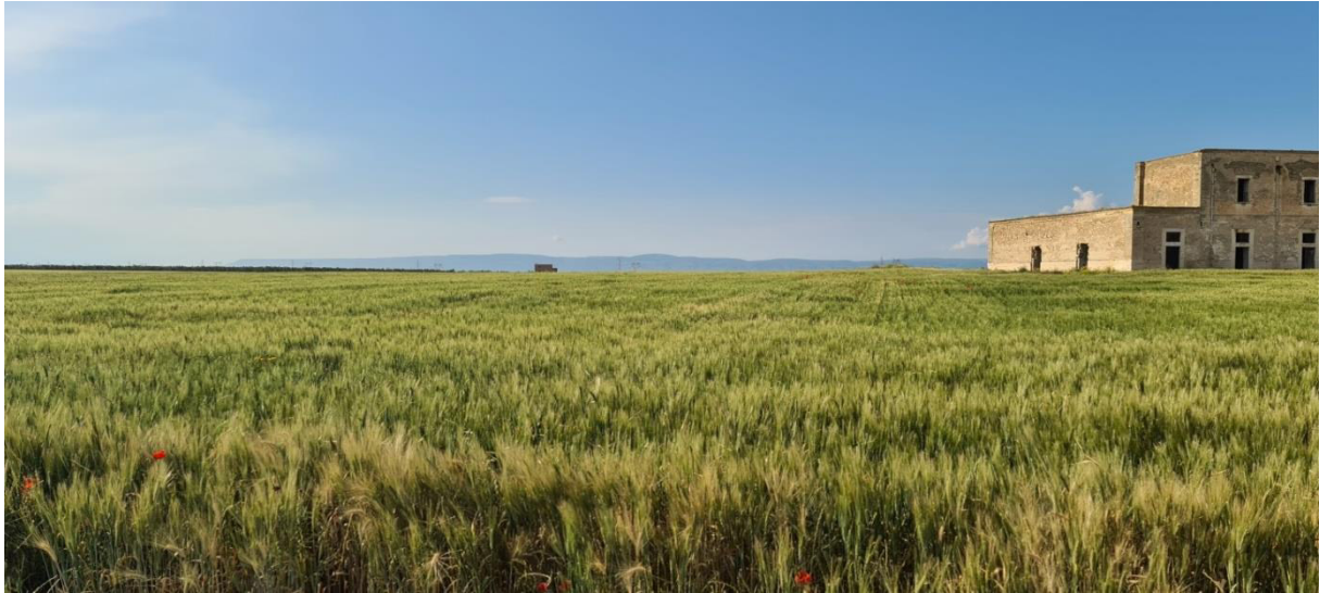
Figura 1-69: Alcune vedute - punto di presa CER01_NV_14 – Casa Posta dei Preti – verso blocchi C,D ed E
