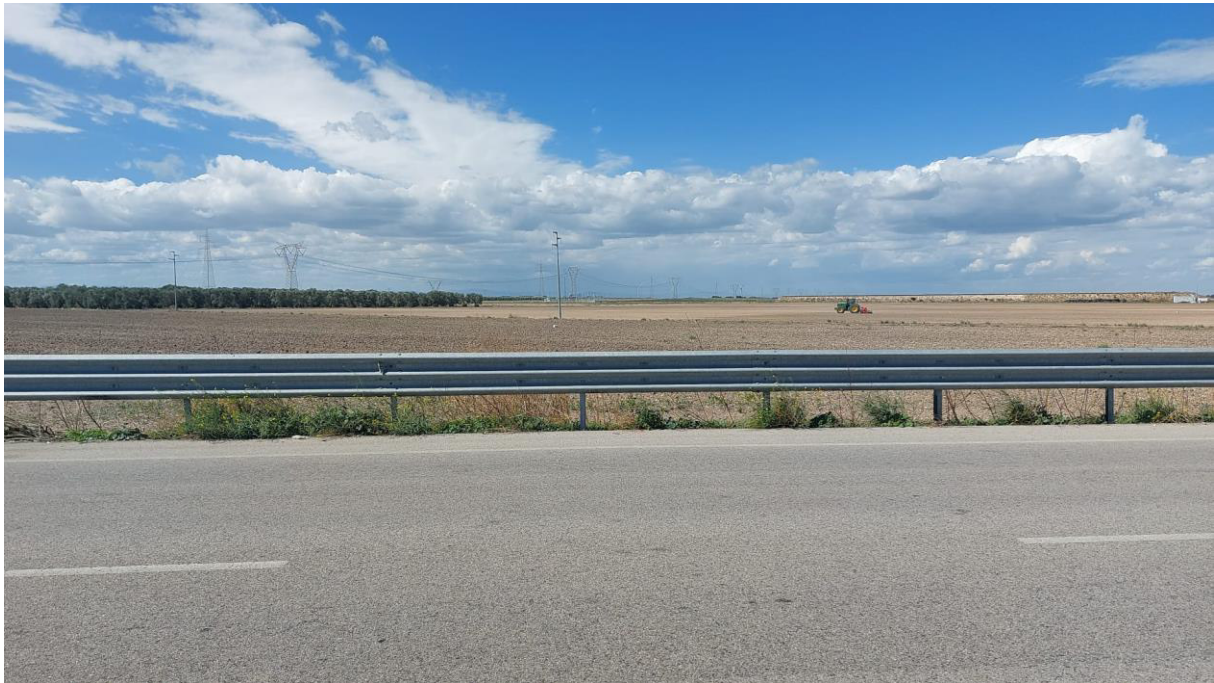
Figura 1-81: Alcune vedute - punto di presa CER01_NV_42_L6 – S.P. 77
