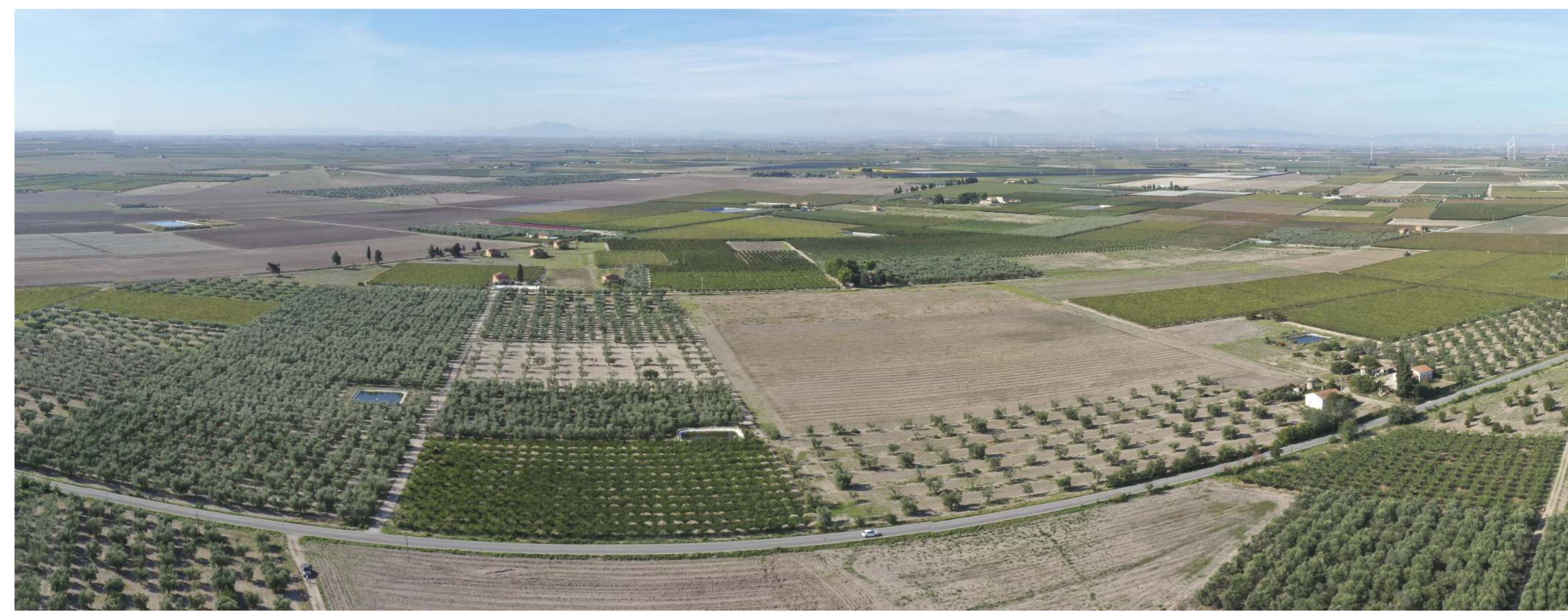
Punto di presa PVF02 - Lat. 41°23'9.70"N - Long. 15°53'22.13"E - Alt. 100 m. - 60° Multipresa (ANTE)
