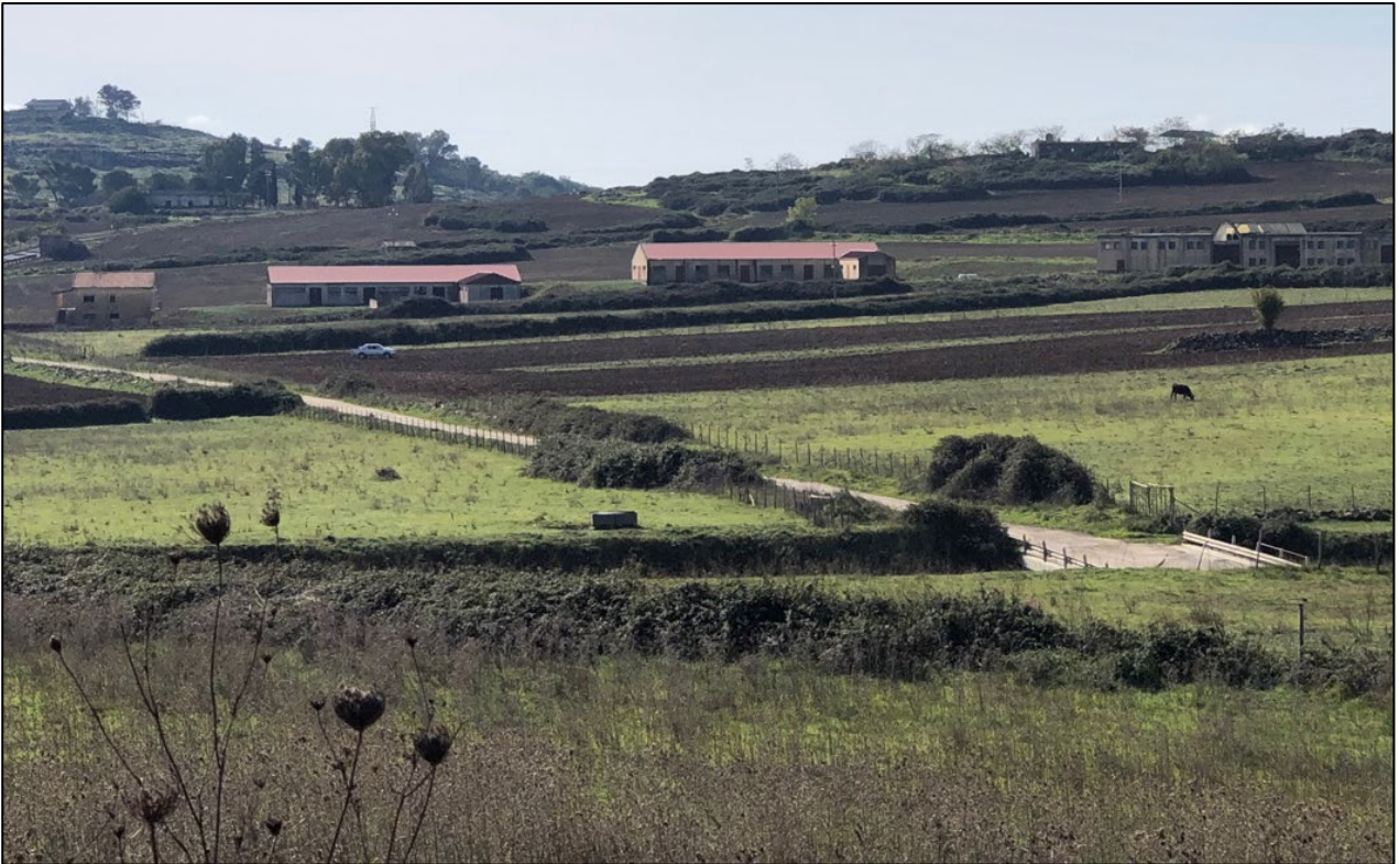
Figura 3. Vista da nord dei capannoni agricoli limitrofi all'area di impianto
