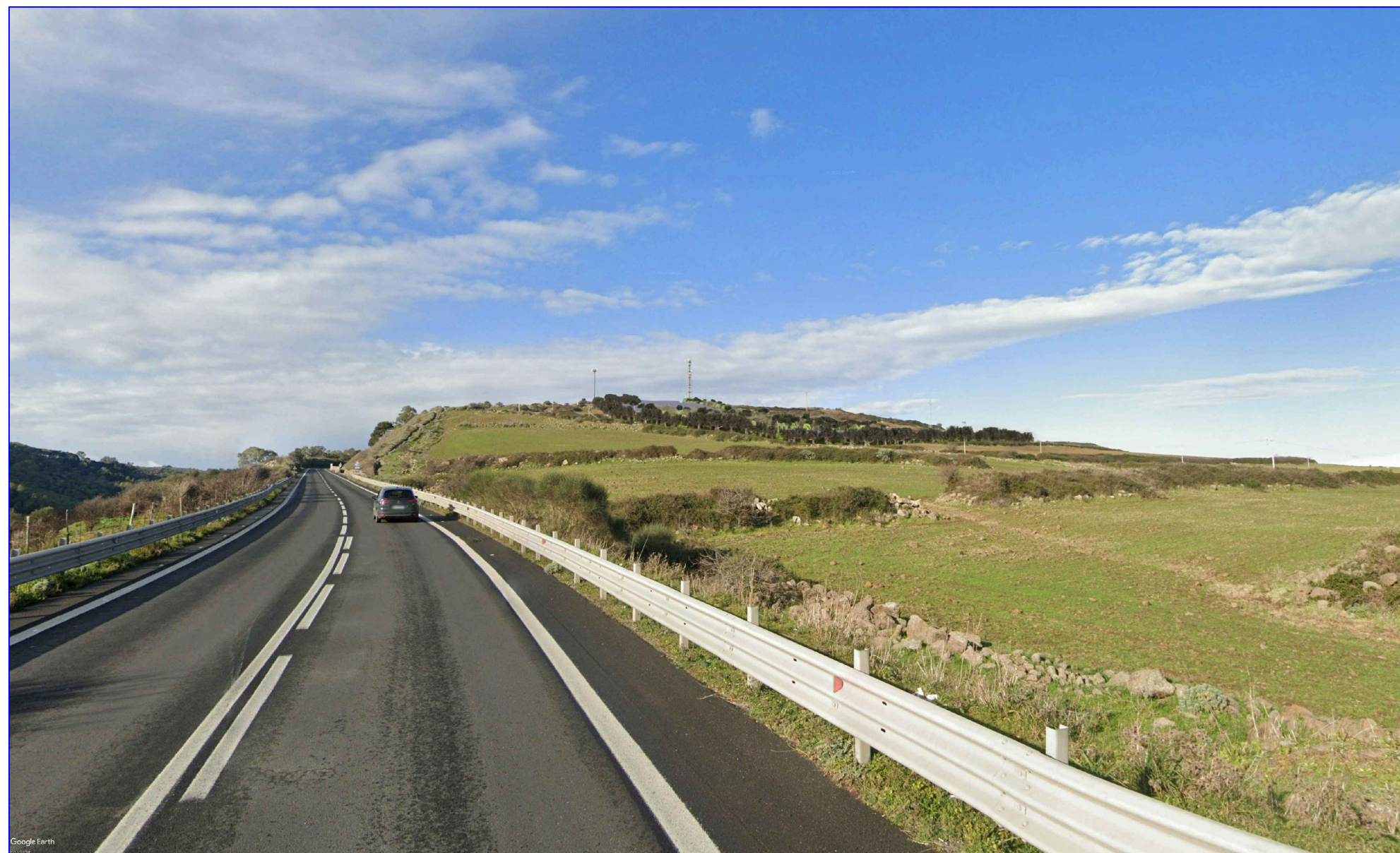
Fotosimulazione veduta dalla SS 514 dell'area est dell'impianto ex-post
