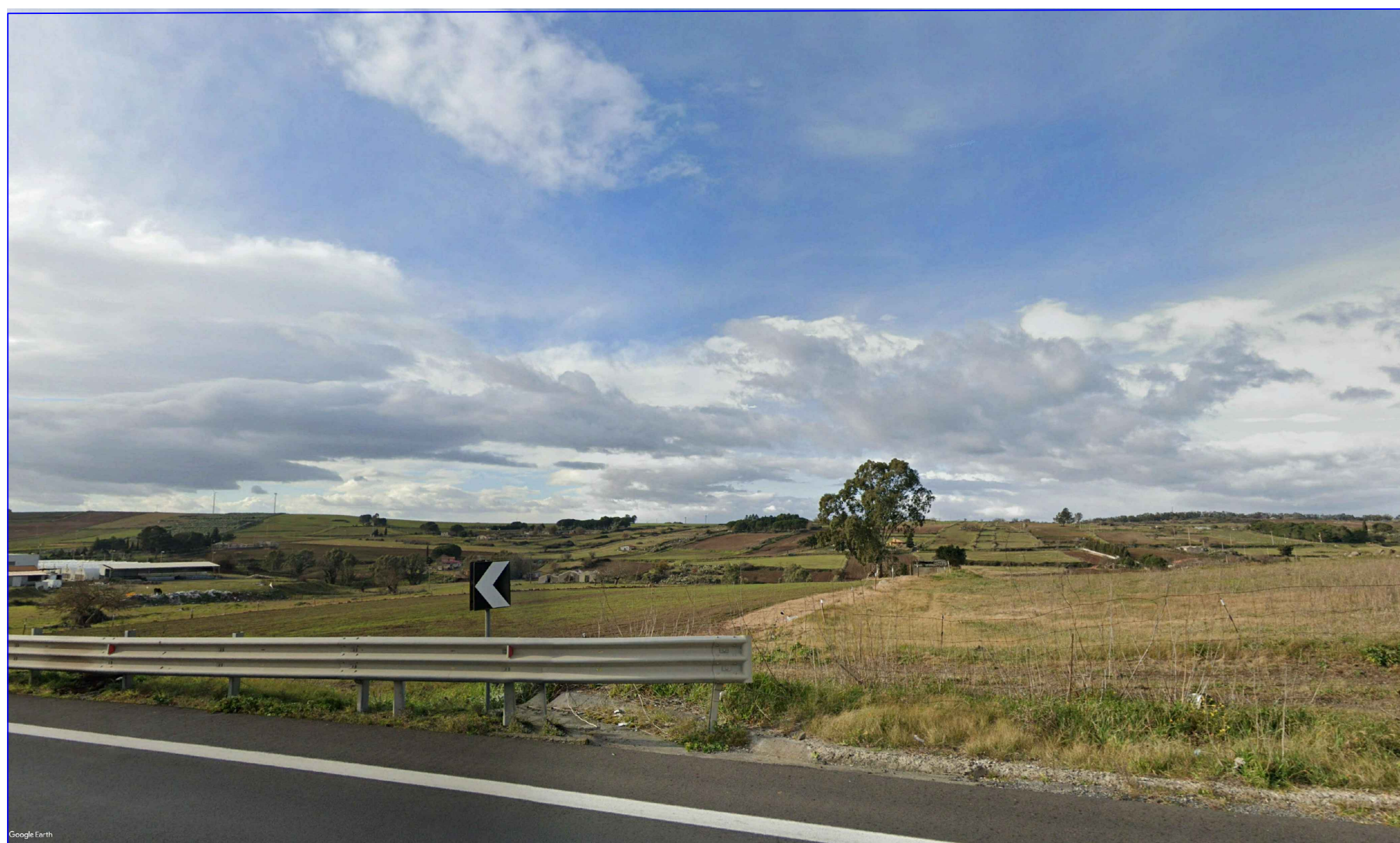
Veduta dalla SS 514 dell'area ovest dell'impianto ex-ante
