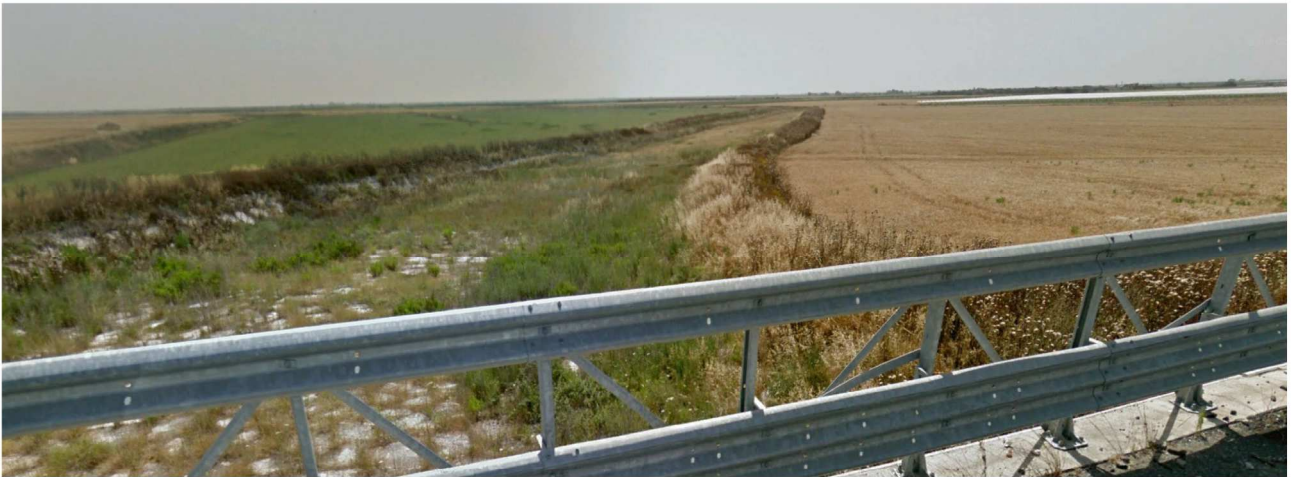
Figura 2-2: Canale Piluso – stato di fatto in corrispondenza dell'intersezione
